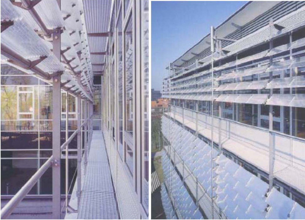
Şekil 4. 12: Prizmatik panellerle uygulanmış gölgeleme sistemi (OKUTAN, 2008)
