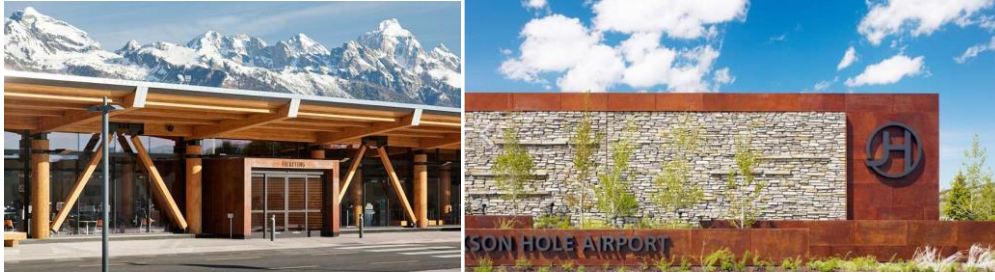
Şekil 4.13: Jackson Hole Ahşap Havaalanı Dış Görünüş [URL-7]
