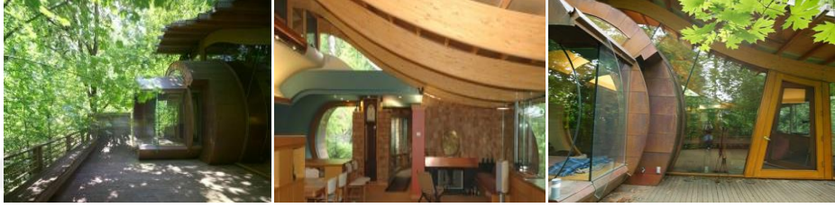
Şekil 4.46: Wilkinson Organik Ahşap Residence Görünüş [URL-17]
