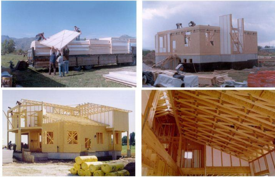
Şekil 3.3: Ahşap Yapı Kooperatifi / Afyon
