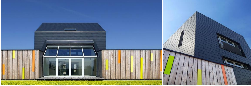
Şekil 4.26: CO2 Saver Laka Gölü Ahşap Kaplamalı Ev [URL-12]
