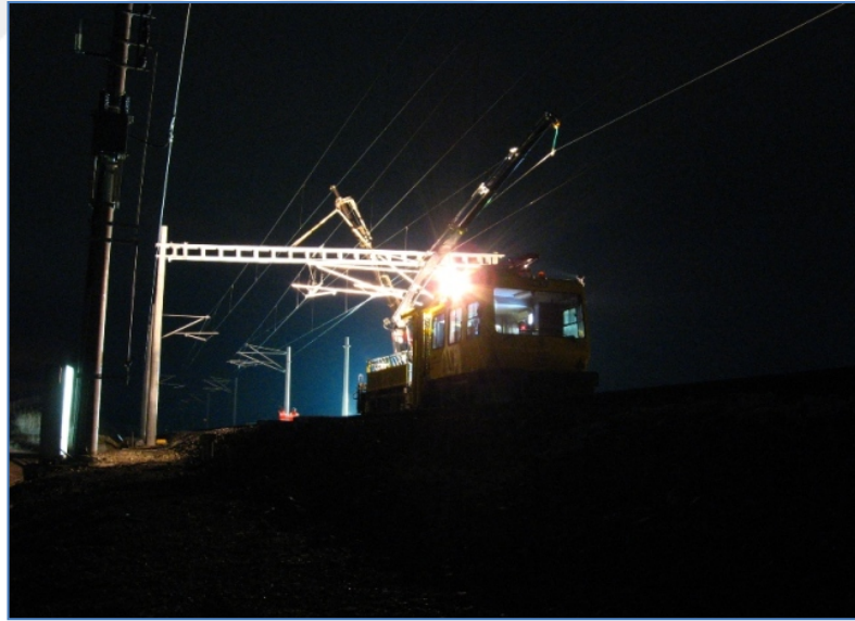
Şekil 2. 6 : Ray Bakım Çalışması
