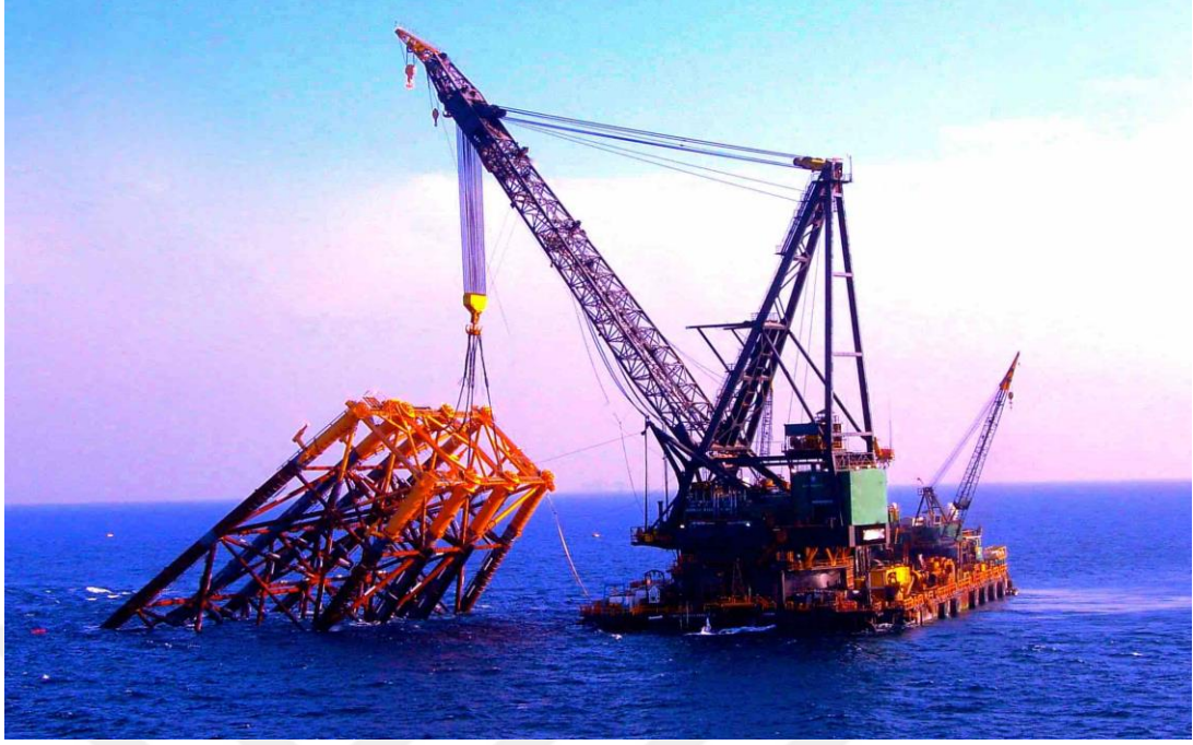
Şekil 2.10: Bir AD jacketin montaj aşaması (Url-11).
