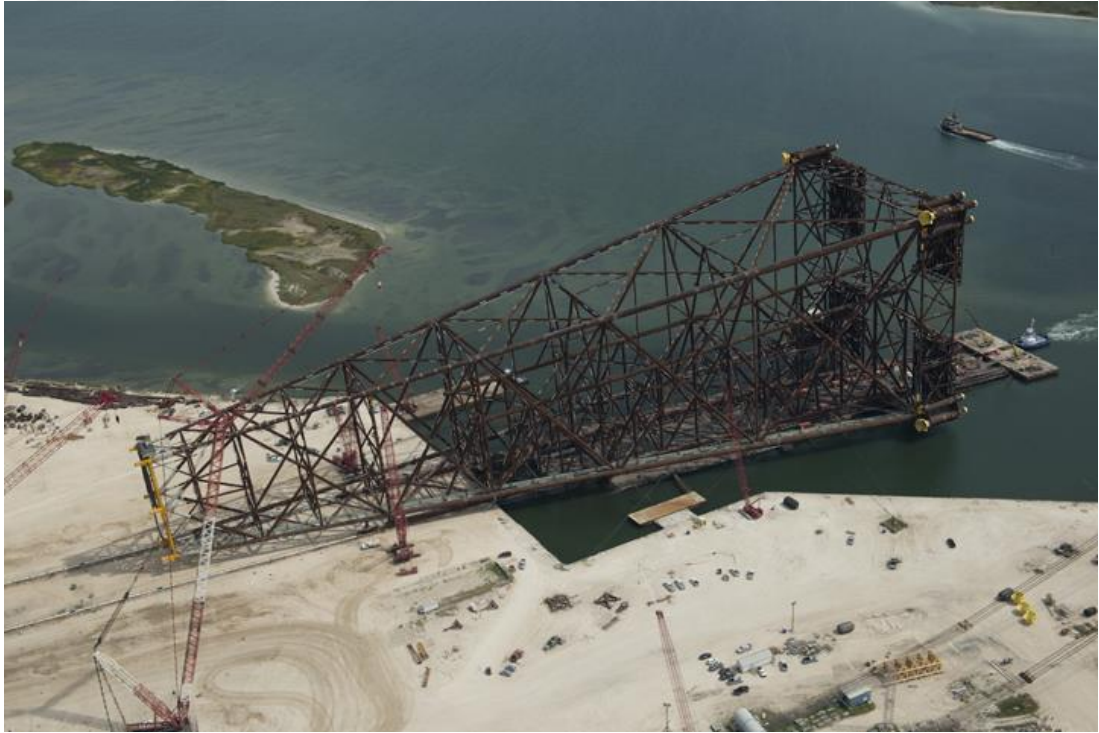
Şekil 2.7: Bir AD jacketin yükleme aşaması (Url-8).
