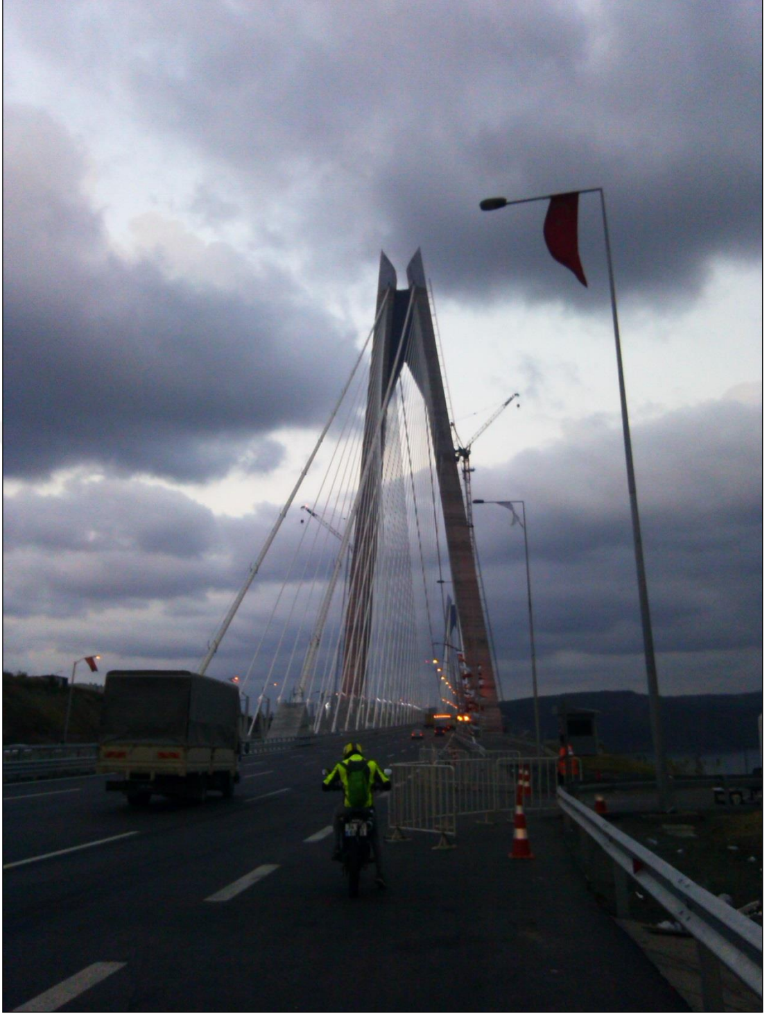
Şekil 1.1: Yavuz Sultan Selim Köprüsü
