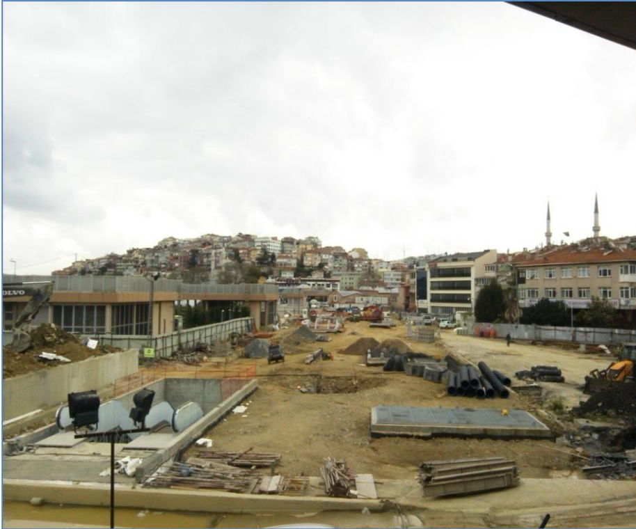
Şekil 1 6: Üsküdar-Ümraniye Metro Hattı Üsküdar İstasyonu
