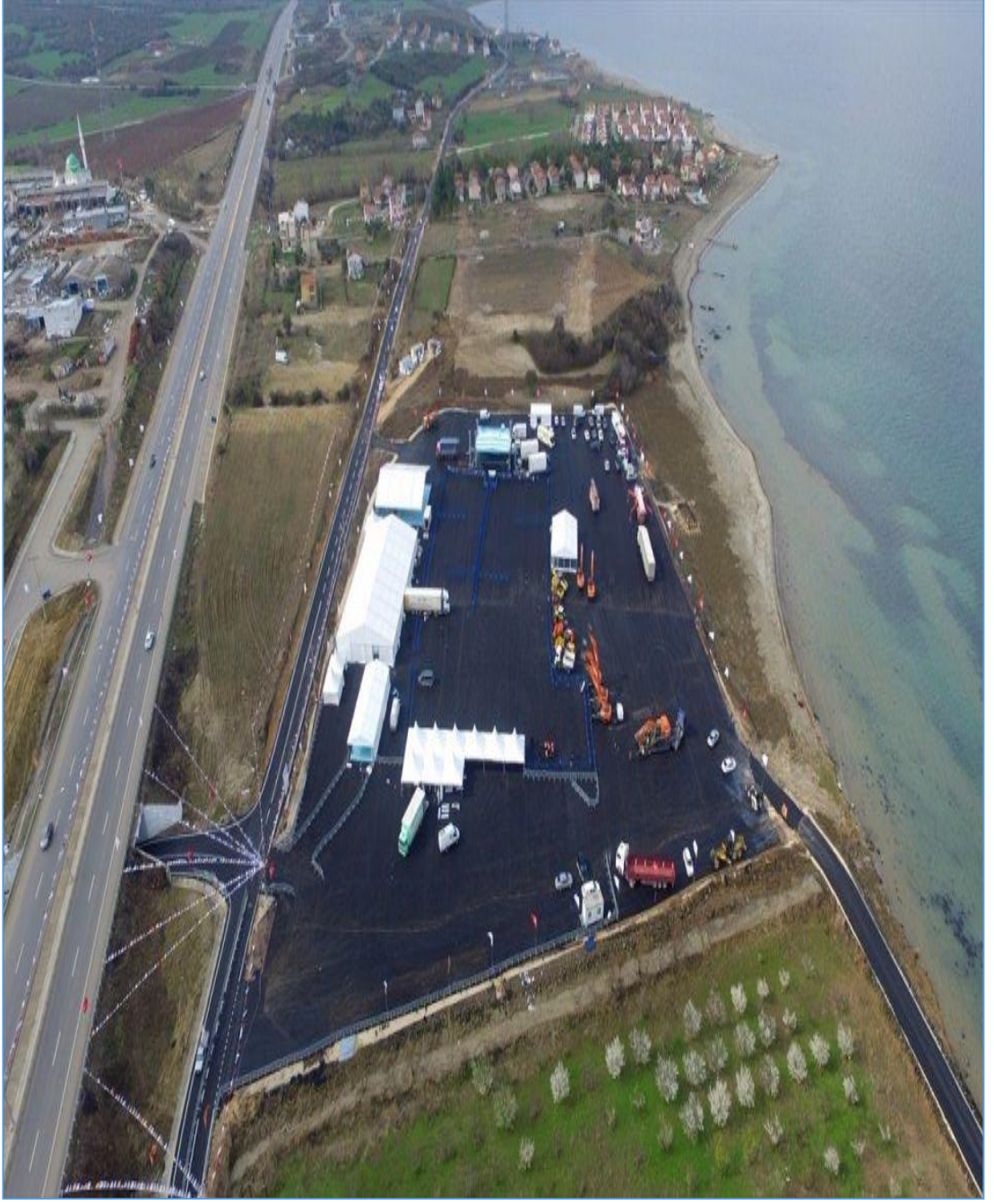
Şekil 3.10 : Çanakkale Köprüsü Şantiyesi. (Kızıldaş, 2016: 3)
