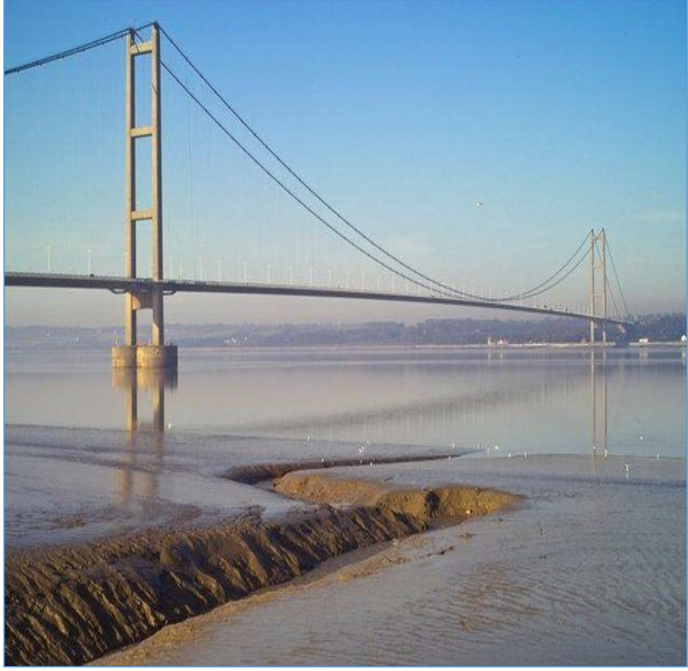
Şekil 3.16 : Humber Köprüsü, İngiltere. (Kızıлтаş, 2016: 3)
