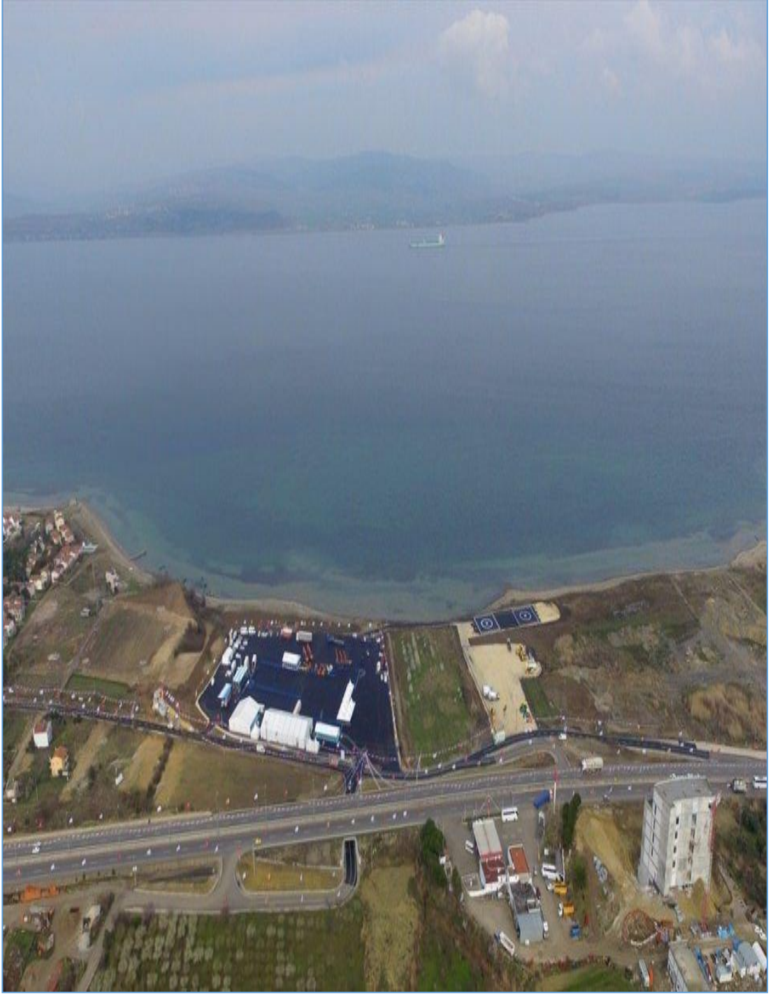
Şekil 3.12 : Çanakkale Köprüsü Temeli Genel Görünüm. (Kızıldaş, 2016: 3)
