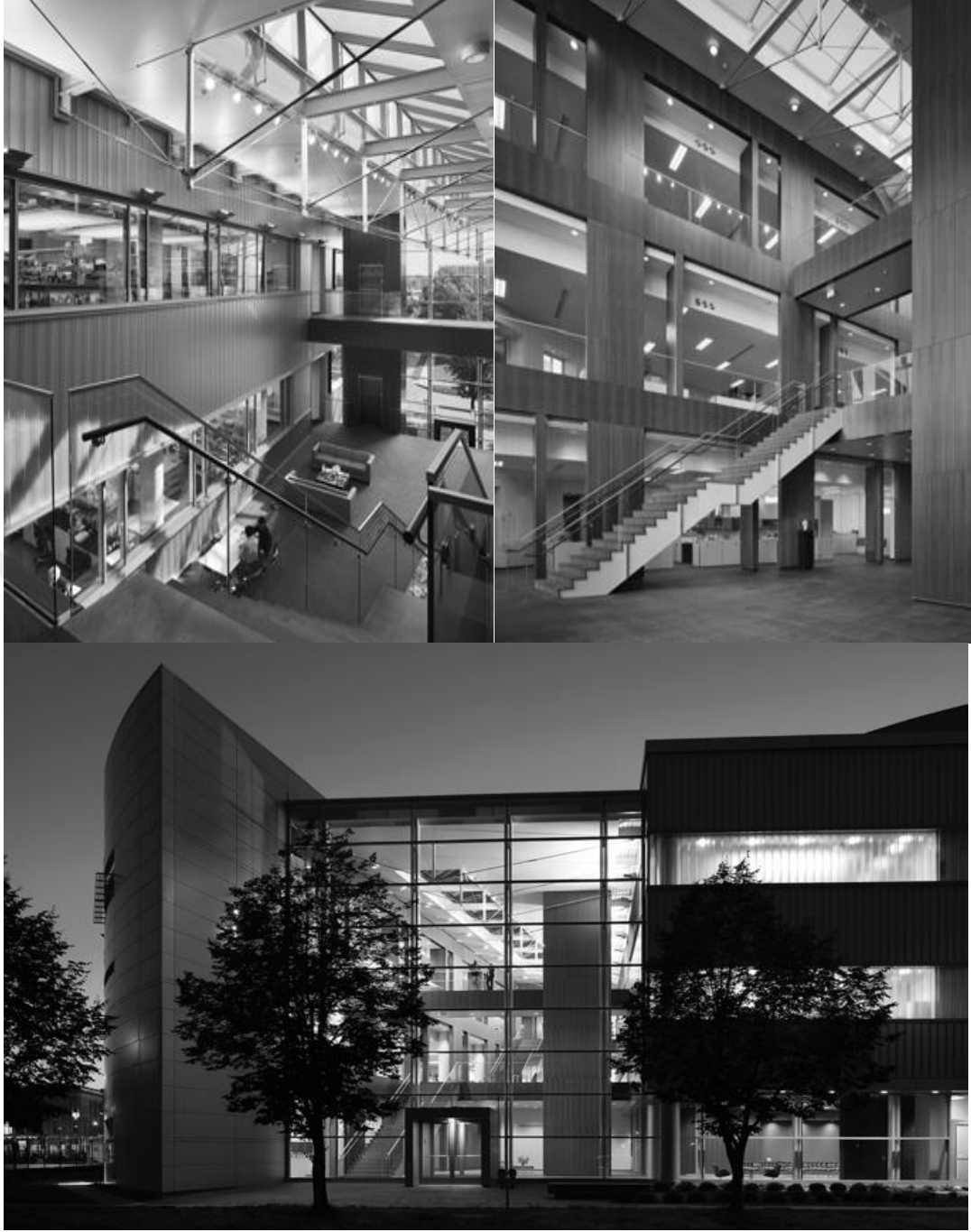
Şekil 4.2: Farklı geometrisi ve bina şekli ile gün ışığından faydalanmayı optimize eden, Buffalo NY'daki Hauptmann Woodward Araştırma Laboratuvarı Binası
