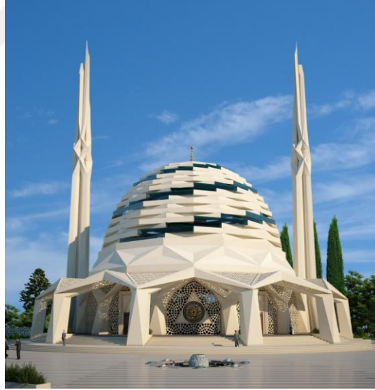
Şekil 5.114: Marmara İlahiyat Camii minare (URL 70)
