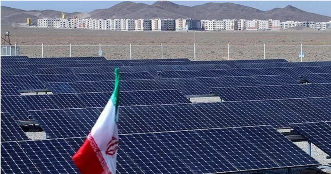
Şekil 6.10: Semnan enerji santrali
