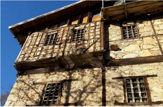
Şekil 5.13: Göz dolma sistem
