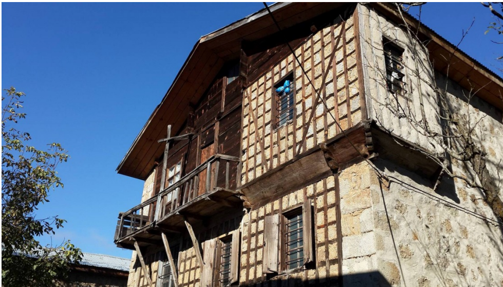
Şekil 5.52: Cephedeki karma sistem
