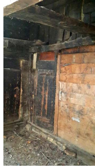
Şekil 5.75: Ashaneleri bağlayan ara kapı
