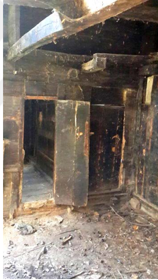
Şekil 5.76: Ashaneden oda kapısı
