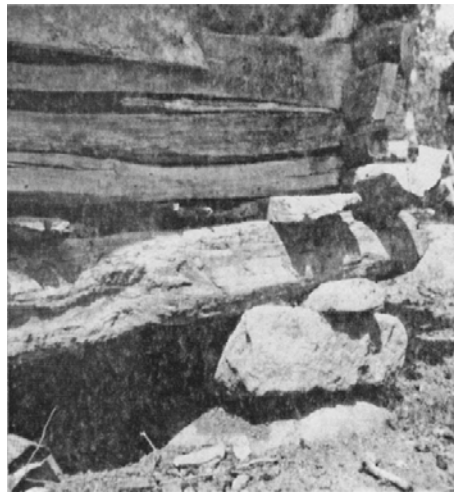
Şekil 4.6: Kasnağı dengeli yerleştirmek için tomruklar ile yüzey toprağı arasında yerleştirilmiş iri taşlar (Dönmez Naza, Dönmez, 2005)
