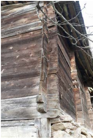
Şekil 5.67: Kurtboğaz geçme Şekil 5.68: Çatı
