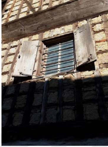
Şekil 5.51: Yapının göz dolma yapım sistemi
