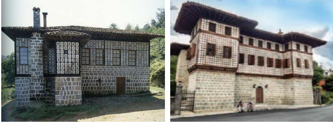
Şekil 4.40: Göz Dolması Sistem (Eskiçırak, 2009) (Güler, Bilge 2013)
