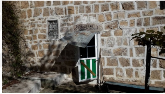
Şekil 5.20: Zemin kata açılan giriş kapıları
