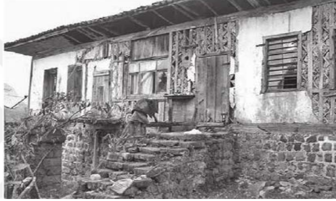
Şekil 4.45: Çakatura yapım sisteminde inşa edilmiş konut (Güler, Bilge, 2013)
