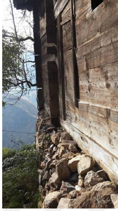
Şekil 5.77: Karma sistem ve Kurtboğaz geçme detayı
