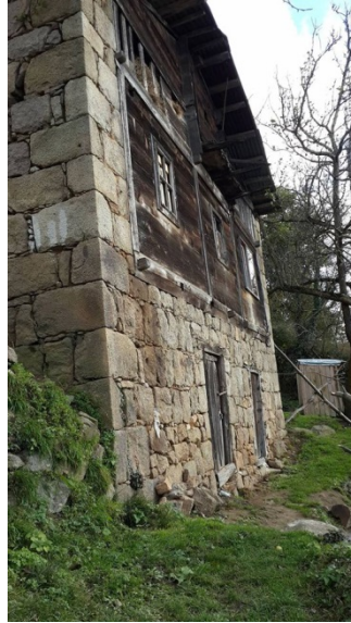
Şekil 5.90: Cephede görünen karma sistem
