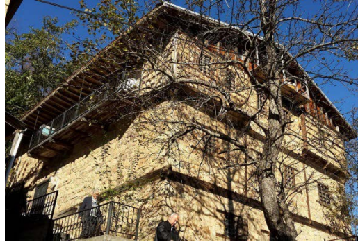
Şekil 5.14: Yapının çatı sistemi
