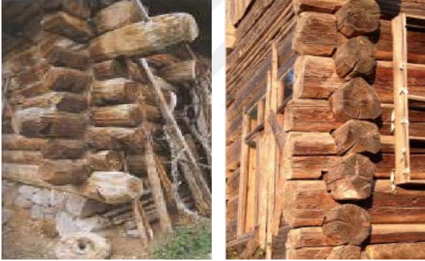
Şekil 4.35: Karaboğaz geçme detayı (Usta, Onur, Ziyrek, 2012) (Bayram 2014)
