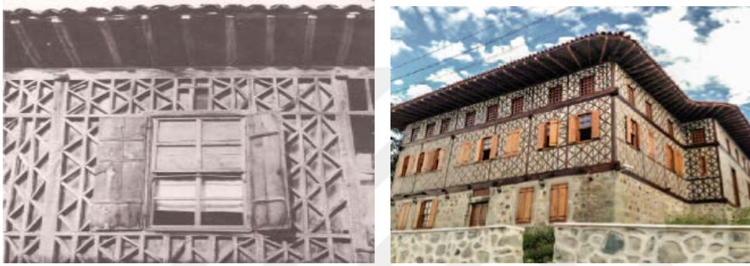
Şekil 4.44: Muska dolma sistem duvar örgüsü.
