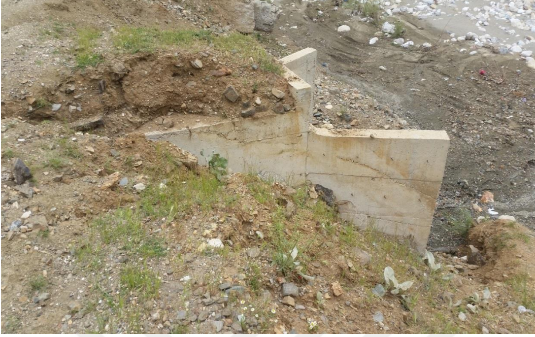
Şekil 8.3: Yanlıř ve yetersiz kanat duvarı aıklığına sahip menfezde k y yolu imlasının g çmesi
