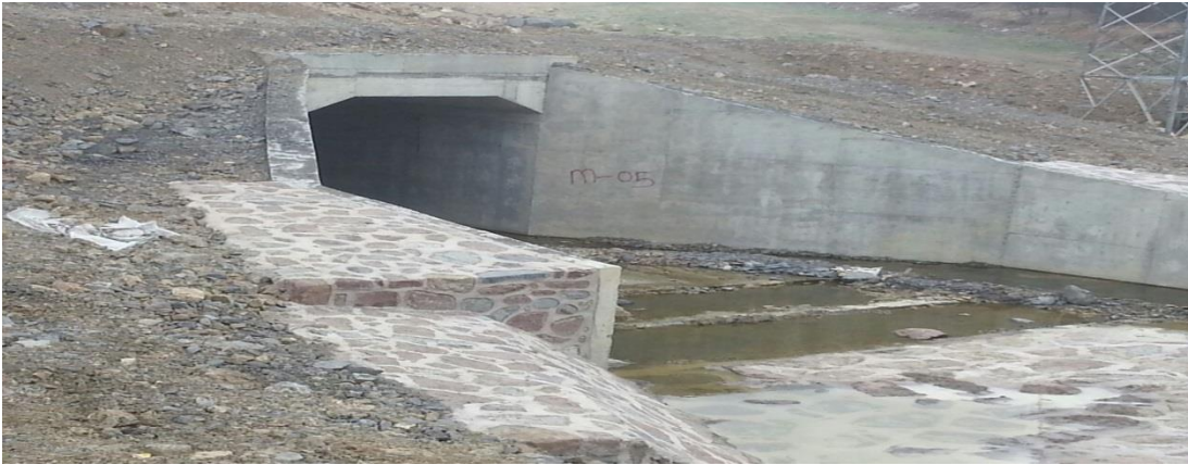
Şekil 6.12: Menfezlerde taş pere uygulaması
