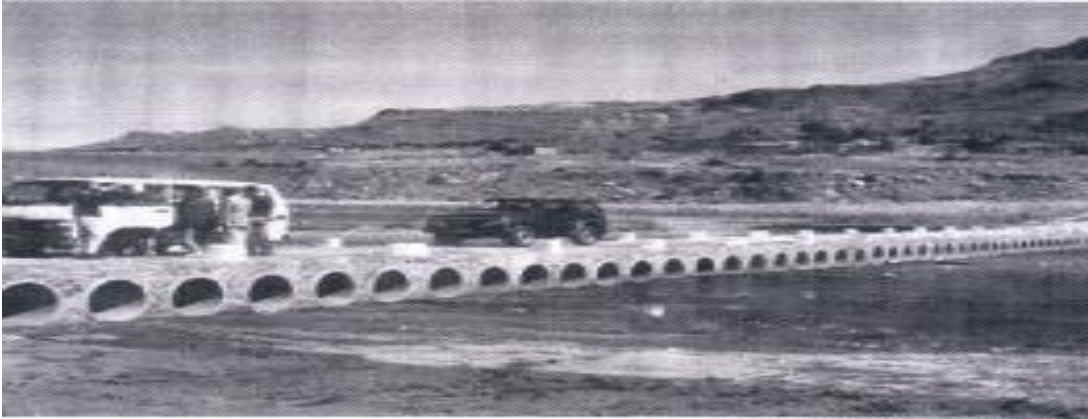
Şekil 6.19: Nehir geçişi uygulaması
