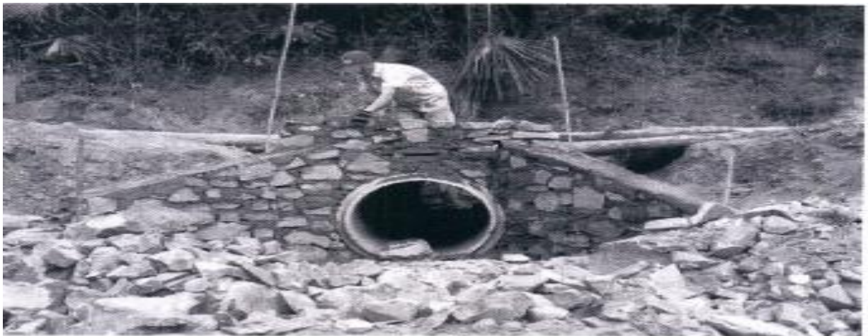
Şekil 5.2: Büz çıkışı kanat duvarı ve pere uygulaması
