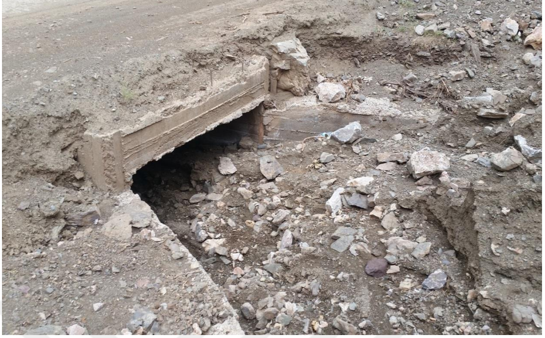
Şekil 8.2: Memba tarafında süprüntü malzeme biriken menfez
