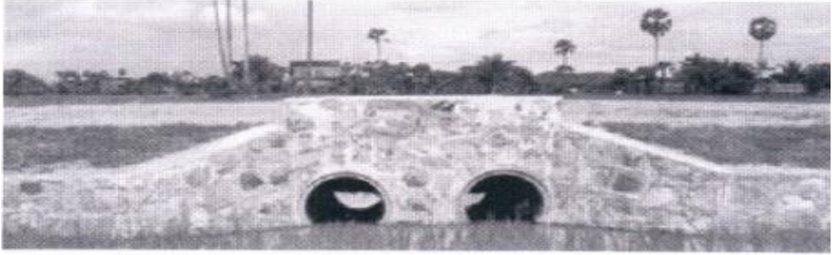
Şekil 5.7: Büz çıkışı taş duvar kanat uygulaması
