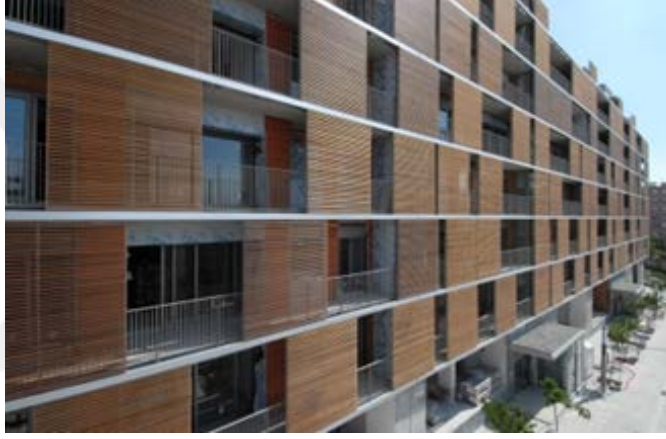
Şekil 2.3: Hastane Binası, İspanya
