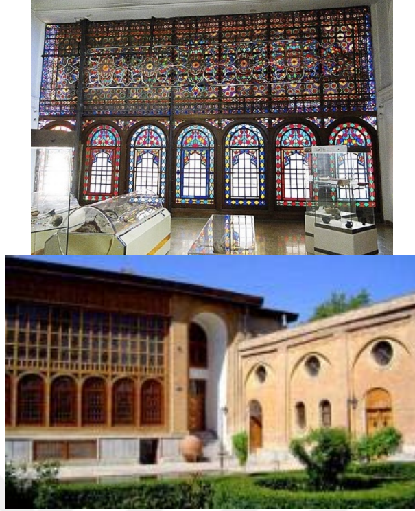
Şekil 3.28: Sanandac şehrinde 150 yıl önce yapılan kacar dönemin 'de habibi köşkü görülmektedir. Bu yapıda kışlık ve yazlık odalarda orsi kullanmaktadır.
