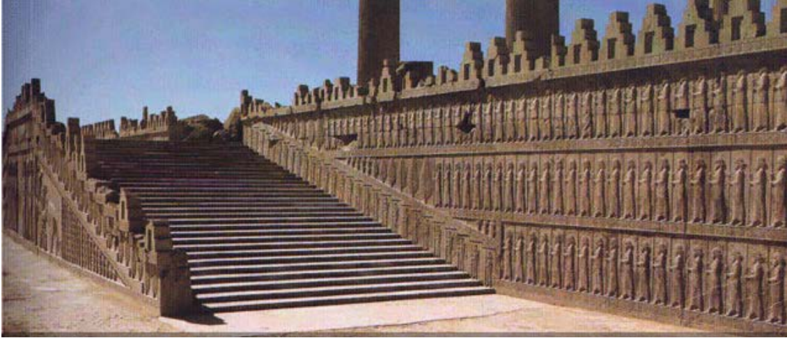
Şekil 3.10: Pers polisin merdivenleri
