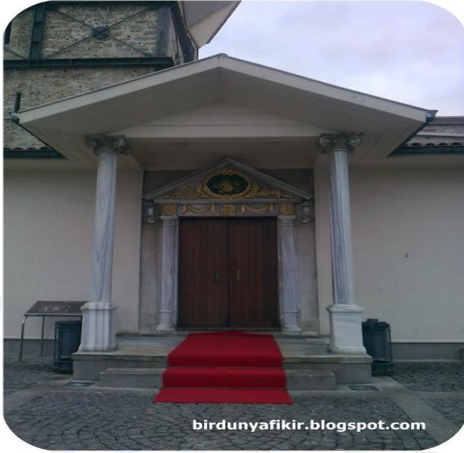
Şekil 4.13: Kız Kulesi Giriş Kapısı
