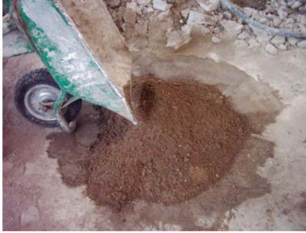
Şekil 3.5: İnce sıva harcı için kum 'un hazırlanması(30)
