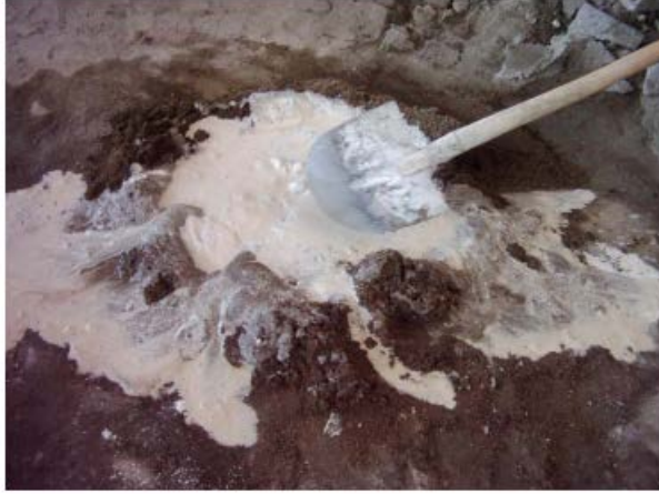
Şekil 3.6: Kum ve kireç 'in karıştırılması(30)
