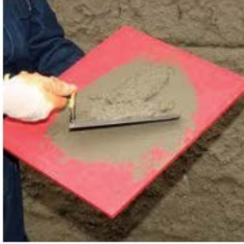
Şekil 3.2: Mala kullanılarak duvar sıvanması(28)
