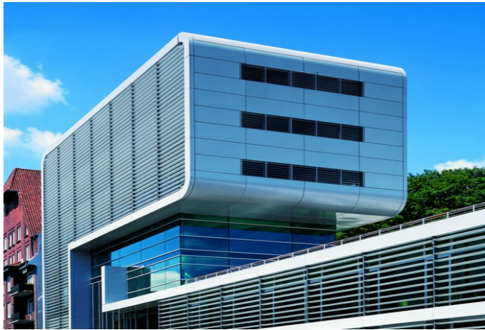
Şekil 3.32: Alüminyum Kompozit Panel uygulama örneği(49)
