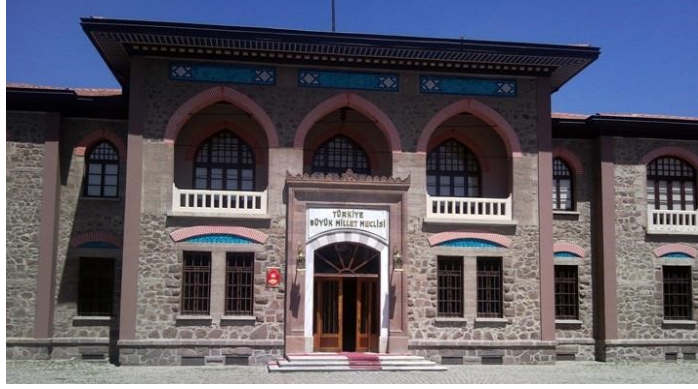
Şekil 2.2: TBMM Eski binası, Kurtuluş Savaşı Müzesi(28).
