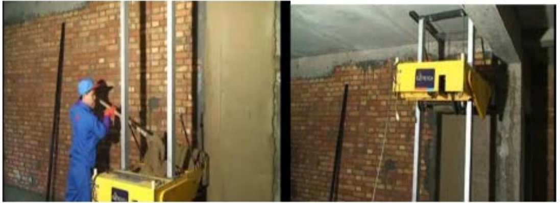
Şekil 3.3: Makine Yardımıyla Duvar Sıvanması(28)
