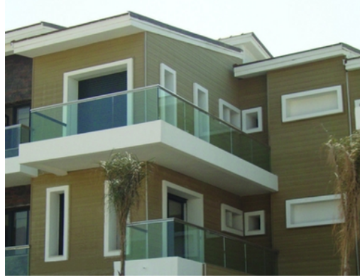
Şekil 3.31: Ahşap Kompozit Panel uygulama örneği(48)
