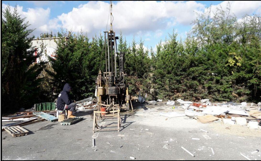
Şekil 3.5: SK 2 sondaj çalışması ve karot sandığından bir görünüm
