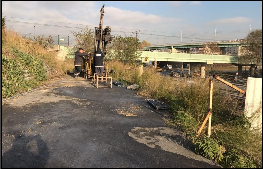
Şekil 3.8: SK 5 sondaj çalışması ve karot sandığından bir görünüm
