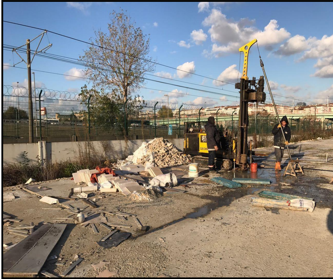
Şekil 3.7: SK 4 sondaj çalışması ve karot sandığından bir görünüm
