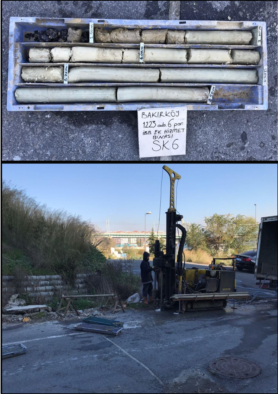
Şekil 3.9: SK 6 sondaj çalışması ve karot sandığından bir görünüm
