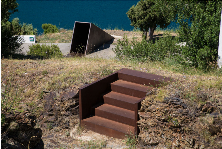
Şekil 5.8. Tünelin girişi ve merdivenler
