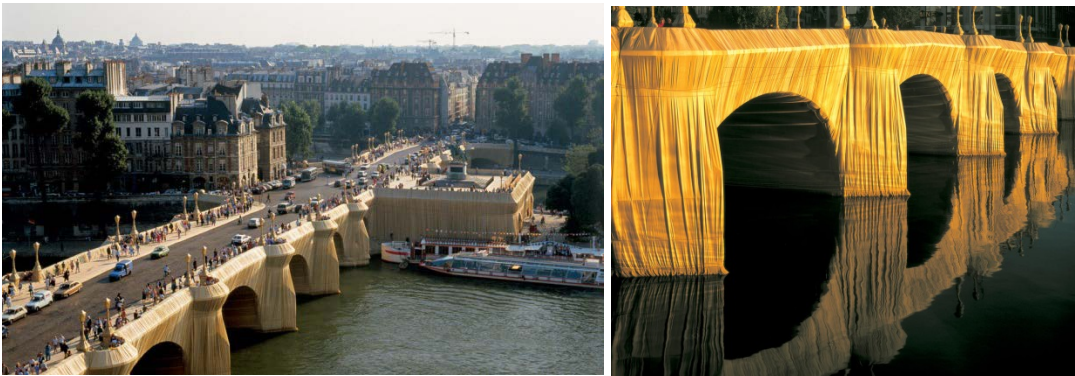
Şekil 4.15: Neuf Köprüsü, Paris [Url-95]
