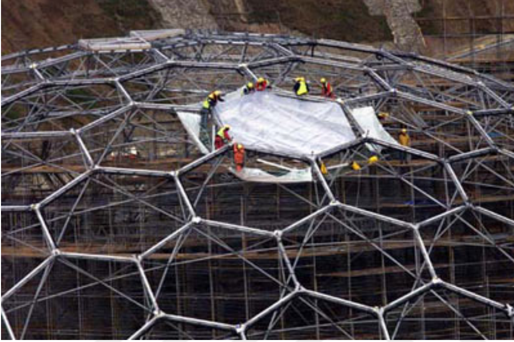
Şekil 6.4: Çelik kafes giydirilmesi [Url-104]
