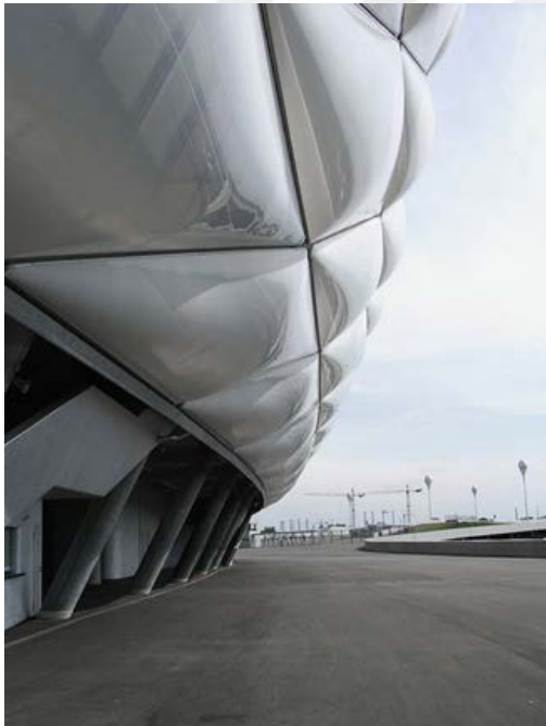
Şekil 6.17: Şişirilmiş ETFE yastıklar ve kesiti [Url-114]
