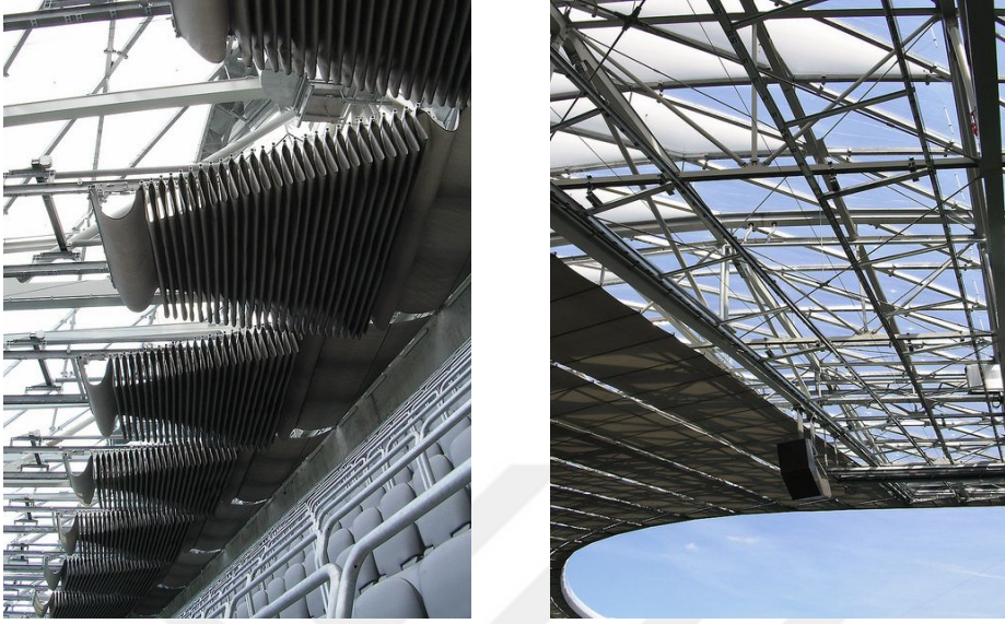
Şekil 6.22: Arena Çatı tente sistemi [Url-121,122]
