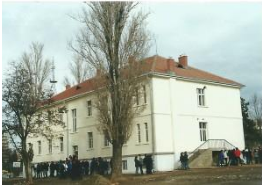
Şekil 6.12. Priştine Belediyesi’nin yıkım kararı öncesi “Xhevdet Doda” binasının görünümü. Şu an aynı konumda “Rahibe Teresa Katedrali” yer alıyor. Müellif: Shyqeri Obertinca (Akt. Besa Shahini)
