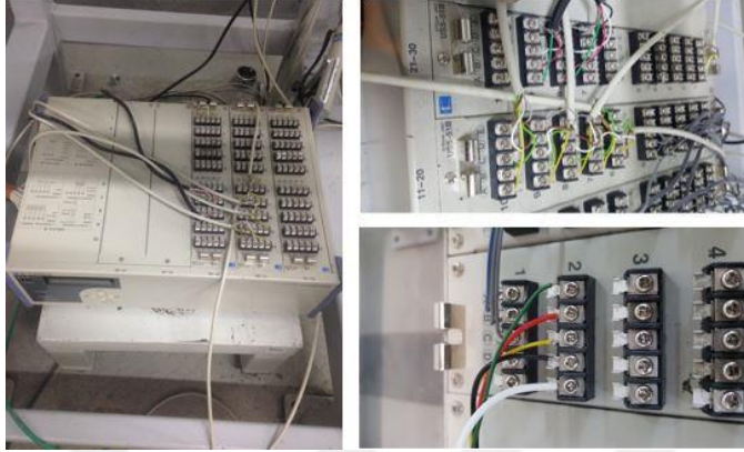
Şekil 2.18: Veri toplayıcı bağlantıları
