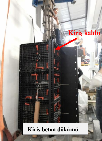
Şekil 2.10: KN04-YP2-6.0 numunesinin imalat aşamalarına ait fotoğraflar
