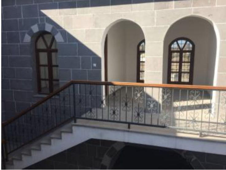
Şekil 4.65: Merdiven ve korkuluklar
