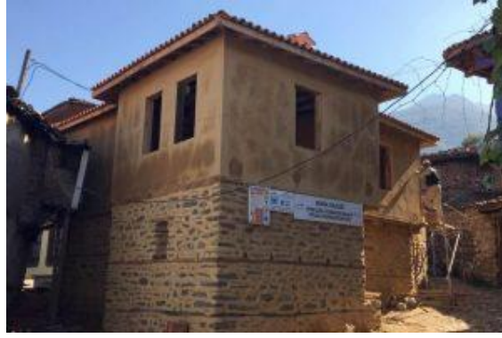
Şekil 2.21: Cumalıkızık geleneksel evleri kentsel dönüşüm sonrası görünüşü
