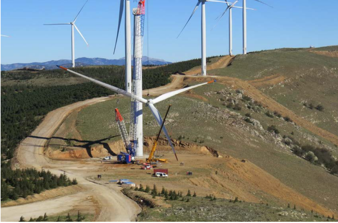
Şekil 4.8 : Rotor'un Makine Dairesine Yerleştirilmesi
