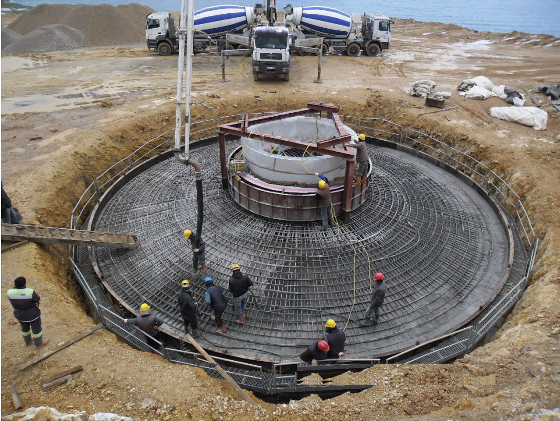
Şekil 3.1 : Rüzgâr Türbinleri Betonarme Temel İnşası
