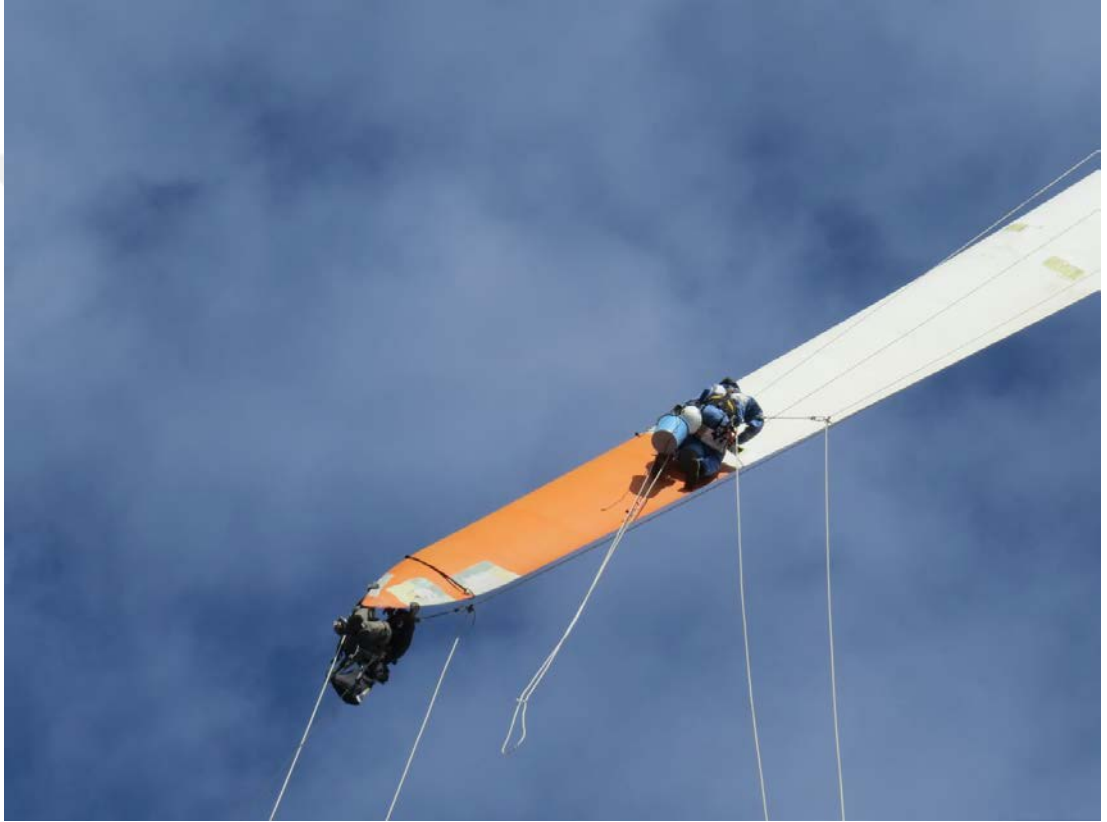
Şekil 4.11 : Kanat Üzerinde Bakım Çalışması
