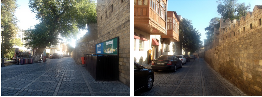
Şekil 5.14: Küçük Kale Sokak boyunca uzayıp giden İçerişehir surları (Chinara RUSTAMLI tarafından çekilmiştir).
