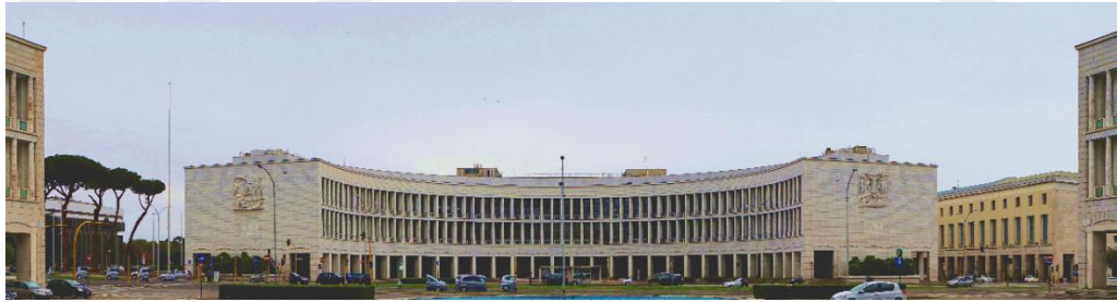
Şekil 4.10: Esposizione Universale di Roma'nın kolonatl cephesi (URL21)
