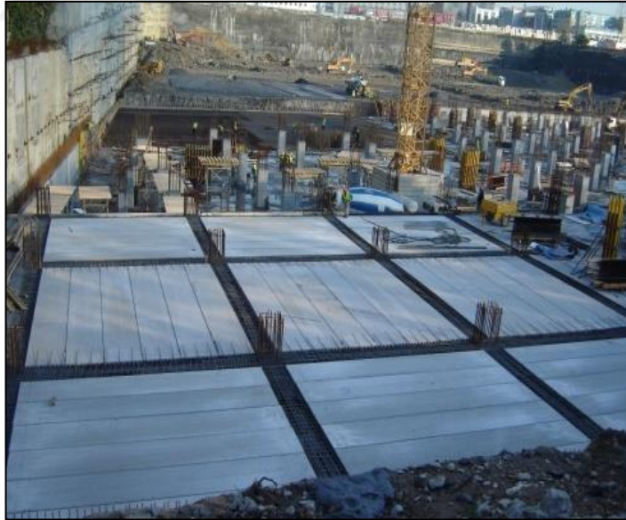
Şekil 3.14: Panel Sistemleri Duvar Olarak (Url. 13).
