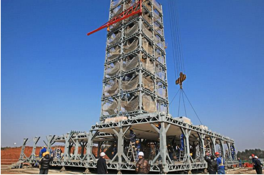
Şekil 6.7: Şantiyede Anında Kurulumu Gösteren Fotoğraf Vinçler Kurulacak Modülleri Yukarı Çekiyor (Url. 24).
