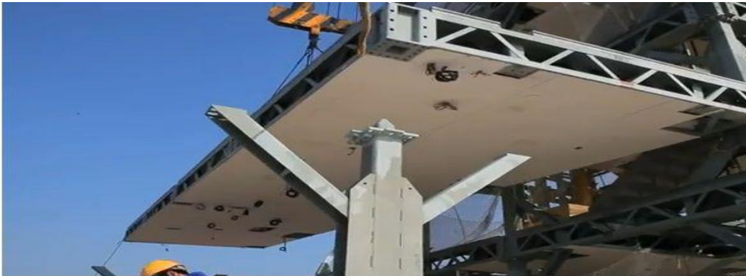
Şekil 6.13: Yük Dağıtım Sistemi Göstermektedir
