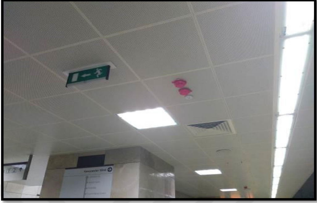
Şekil 5.6. Yangın algılama dedektörleri
