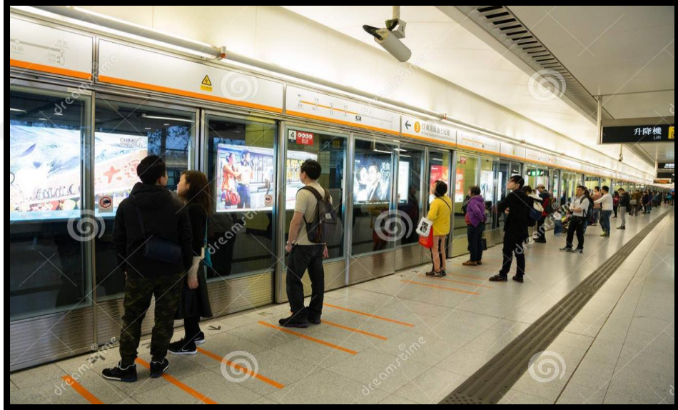
Şekil 5.18. Hong Kong Metrosu PAKS Sistemli İstasyon
