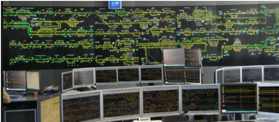
Şekil 9.2. Sinyalizasyon Sistemi Kumanda Ekran Ekranları
