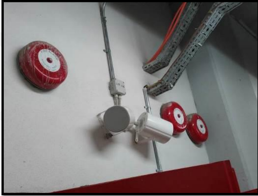
Şekil 5.3. Yangın Alarmları
