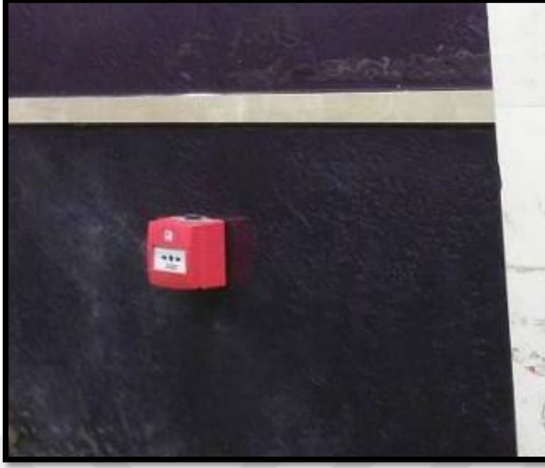
Şekil 5.4. Yangın Alarm Butonu
