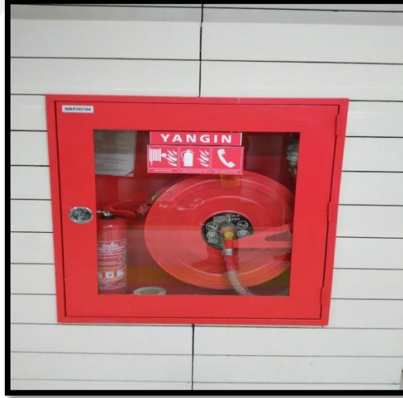
Şekil 5.5. Yangın Dolabı
