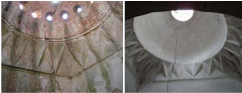
Şekil 0.136: Baklavalı kuşaklama üçgen dizisi örnekleri (Uçak, 2012).
