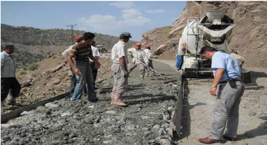
Şekil 6.20: Sason-Derince Grup Köy yolu 2010 yılında yapılan beton kaplama
