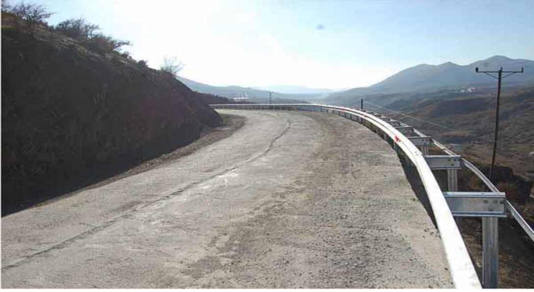
Şekil 6.22: Sason-Derince Grup Köy yolu 2010 yılı Beton yol yapım çalışmaları Sonu
