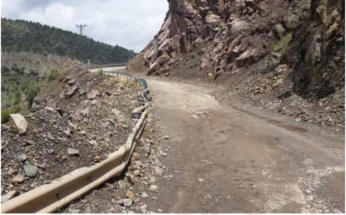
Şekil 6.24: Sason-Derince Grup Köy yolu 2018 Yılı Yol Durumu
