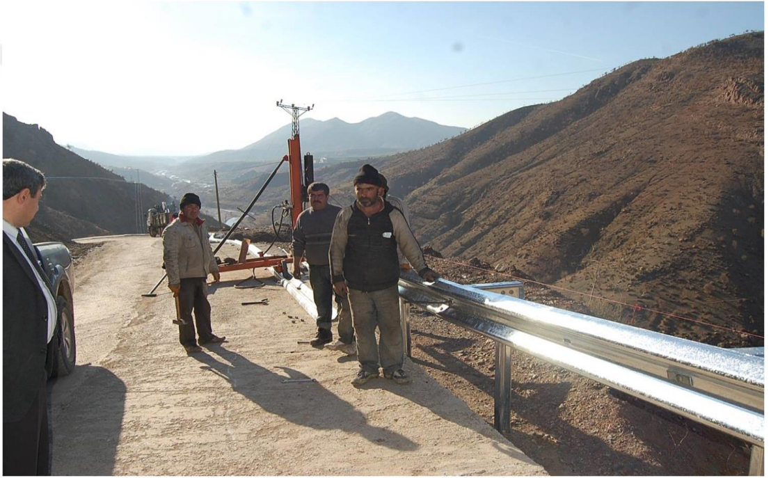
Şekil .6.21: Sason-Derince Grup Köy yolu 2010 yılında Beton Kaplamalı Yol durumu
