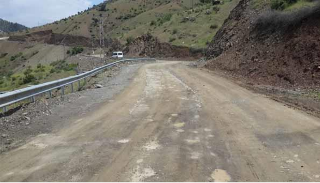
Şekil 6.23: Sason-Derince Grup Köy yolu 2018 Yılı Beton Kaplamalı Yol Durumu
