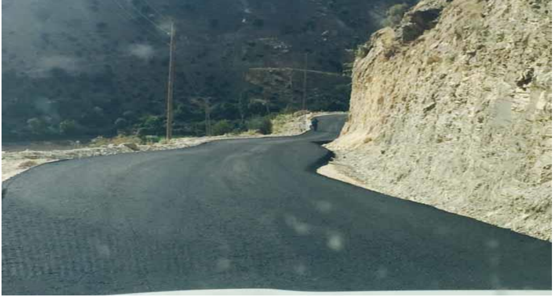
Şekil 6.32. Sason-Derince Grup Köy yolu 2011 yılı Asfalt Kaplama İşi'ne asfalt kaplama durumu
