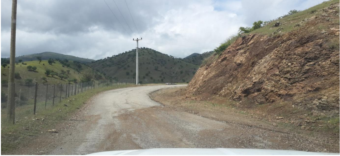
Şekil6.36: Sason-Derince Grup Köy yolu 2018 yılı Asfalt Kaplama Yolda Yol Genişletme Çalışması Sonucu Yol Durumu
