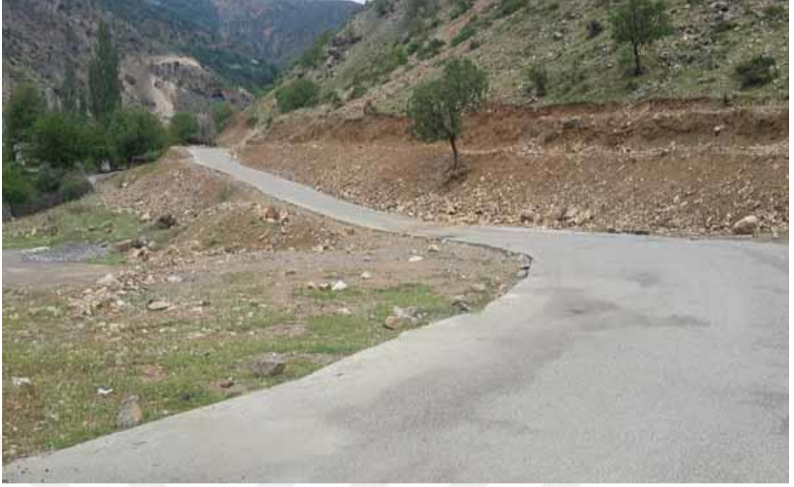
Şekil 6.26: Sason-Derince Grup Köy yolu 2018 Yılında yapılan Yeni Beton Kaplama
