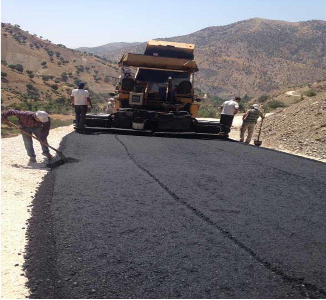
Şekil 6.31: Sason-Derince Grup Köy yolu 2011 yılı Asfalt Kaplama İşi'ne Ait Asfalt Serimi Çalışmaları
