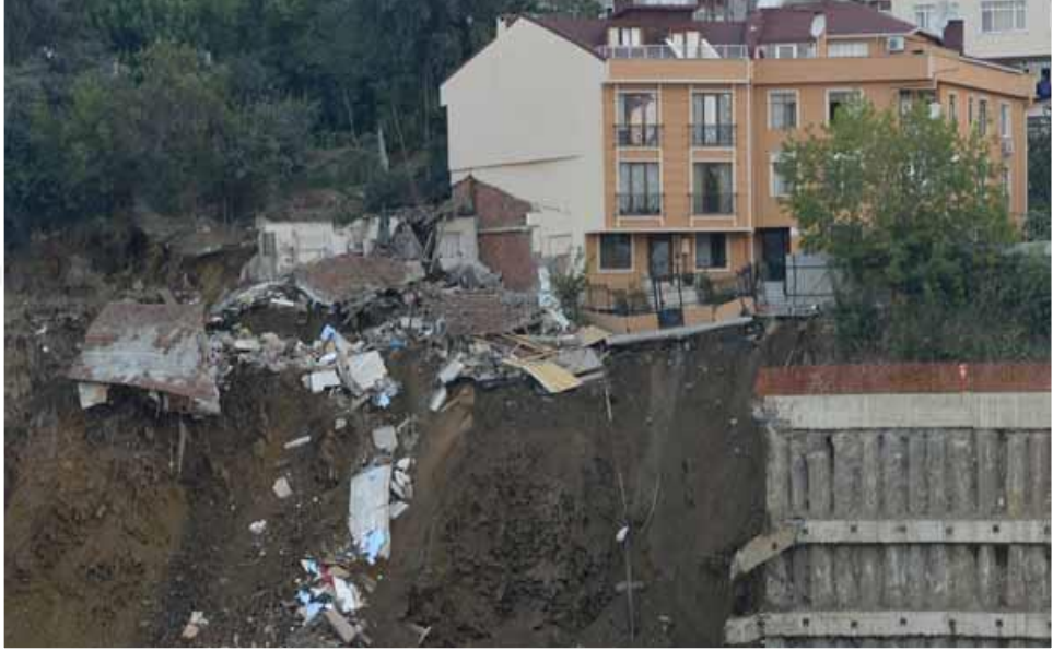
Şekil 4.20: Kazı alanı çökmesi (www.milliyet.com.tr)
