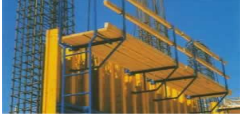
Şekil 4.2: Çelik çıkma iskele
