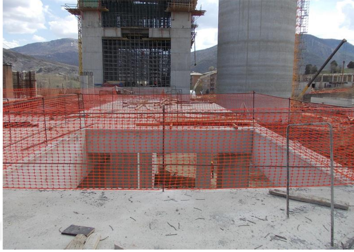
Şekil 4.5: Döşeme üzeri korkuluk uygulaması
