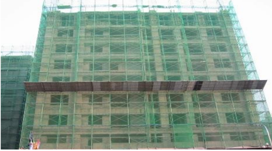
Şekil 4.11: İskele dışı ağ ve platform uygulaması
