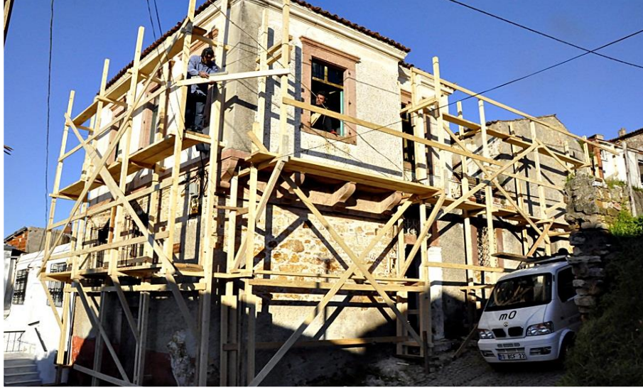
Şekil 4.1: Ahşap iskele
