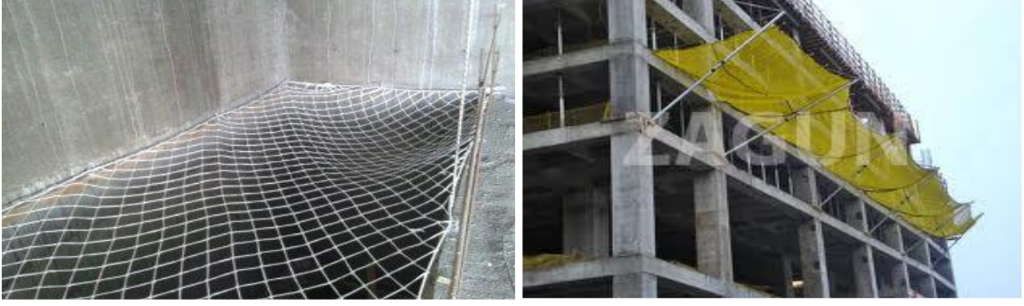
Resim 4.12: Şaft boşluğu ve dış cephe ağ uygulaması
