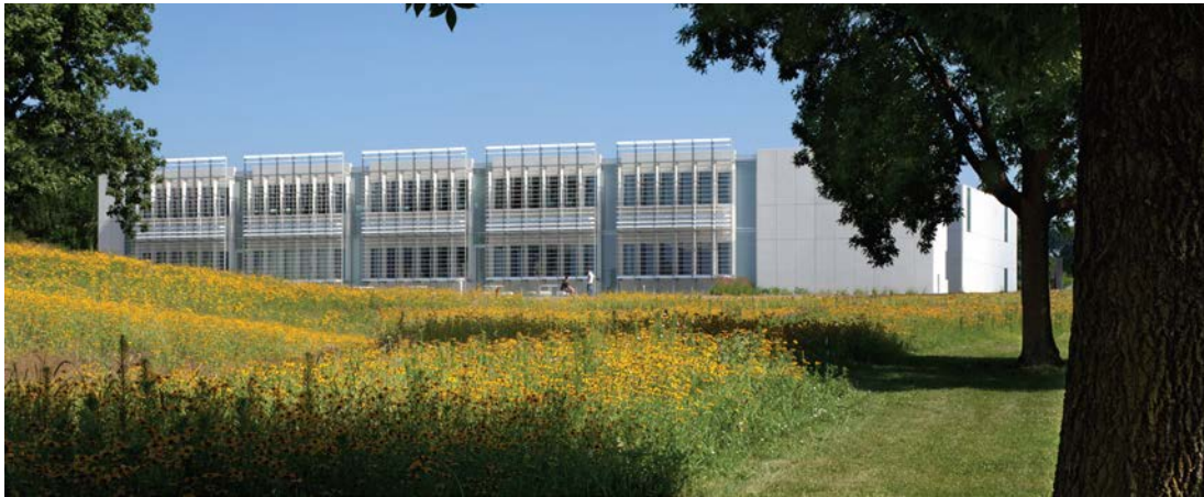
Şekil 5.1:Iowa Kamu Hizmetleri Binası
