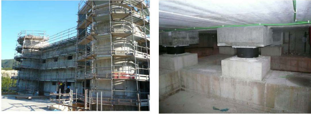
Şekil 2.11: Marzabotto' daki (Bologna) yeni okul, HDRB' ler ve SD' ler.
