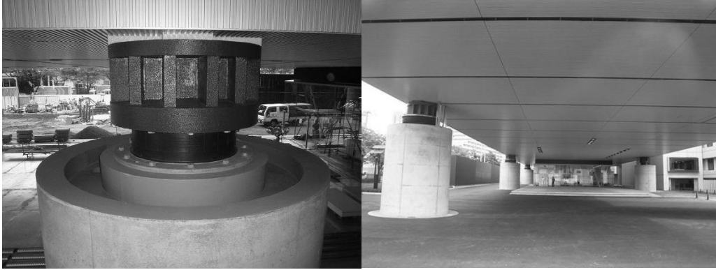
Şekil 2.4: Shimizu Corporation'ın Tokyo Teknoloji Enstitüsü'nün ana binasında birinci kat kolonların üstünde sismik izolatörler (kurşun kauçuk mesnetler).
