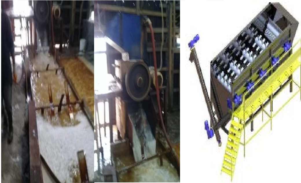
a) Uygun Olmayan Yıkama Havuzu
