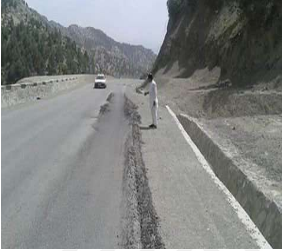
Şekil 3.8: Kaynakların Yetersizliği Nedeniyle Kalitesiz Yol Yapımı, Khust-Afganistan
