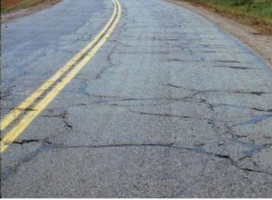
Şekil 2.6: Blok çatlama
