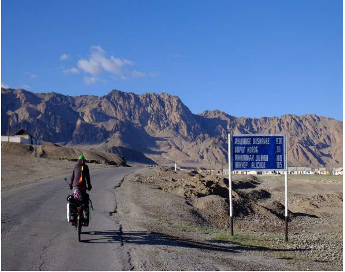
Şekil 3.12: Yetersiz Yol Kaplaması Kalınlığı
