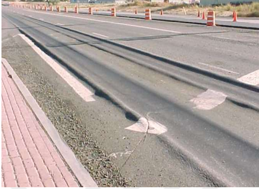
Şekil 2.9: Asfaltta Tekerlek İzi Oluşumu
