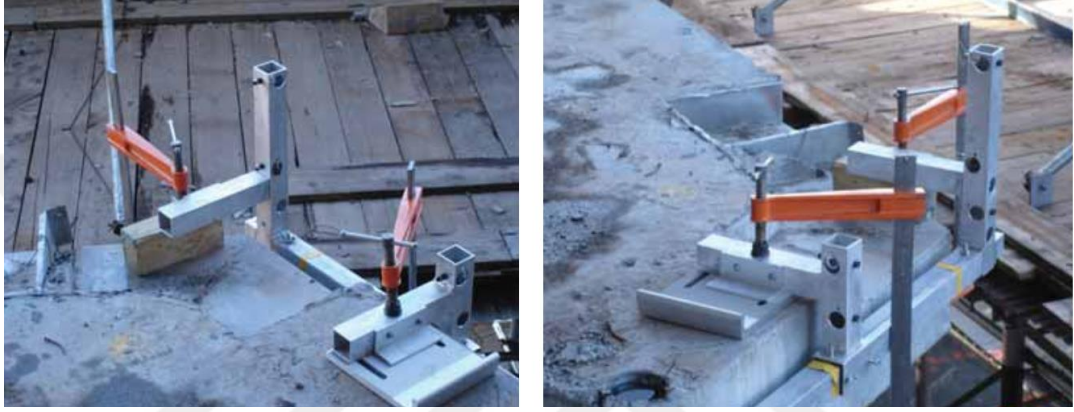
Şekil 5.14: IAC Binası Montaj Yöntemi [51]
