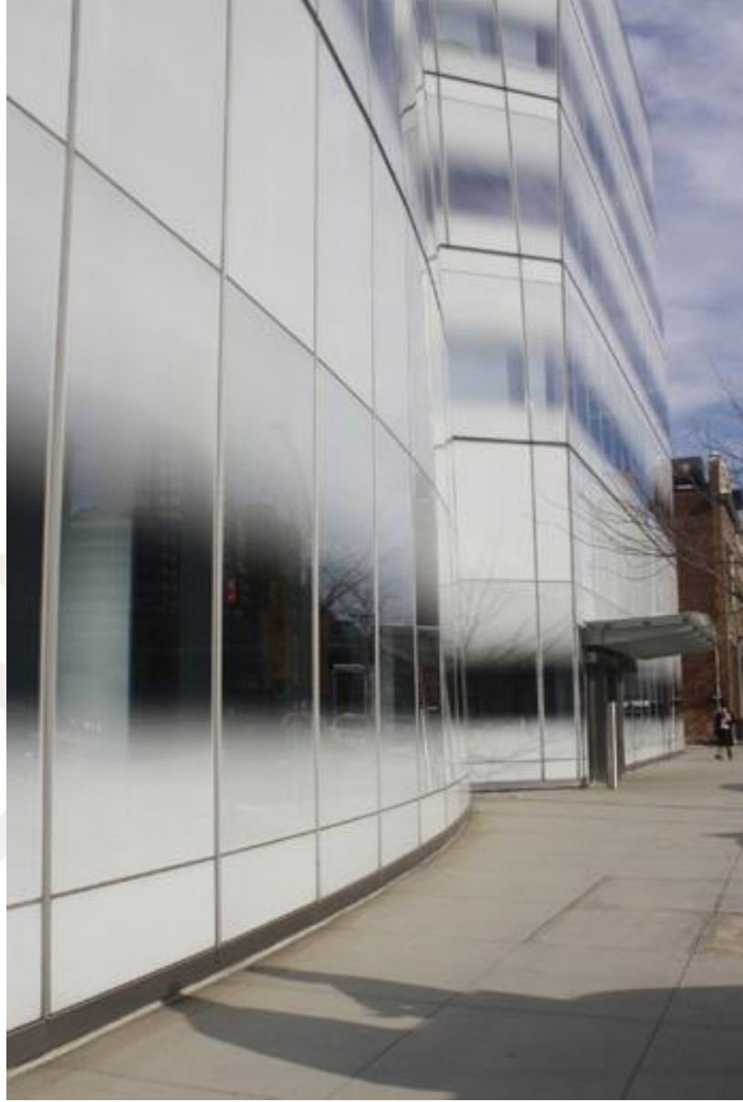
Şekil 5.12: IAC Binası Cam Yüzey Görünüşü [50]
