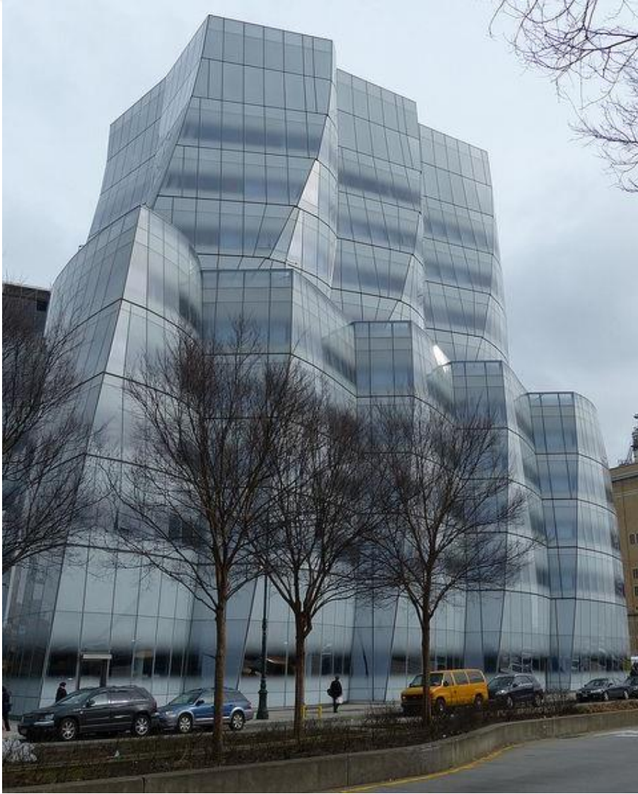
Şekil 5.13: IAC Binası Yan Cephe
