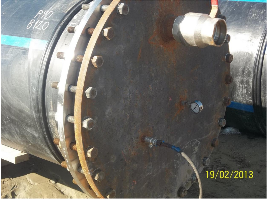
Şekil 4.18: Boru Hattı Kör Flanş Uygulaması
