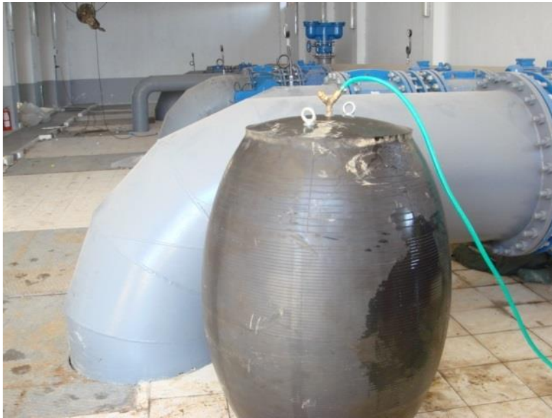
Őekil 4.20: Boru k rleme aparatının ŐiŐirilmesi
