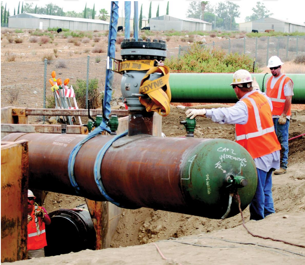
Şekil 4.12: Boru hattı için test kepi uygulama örneği
