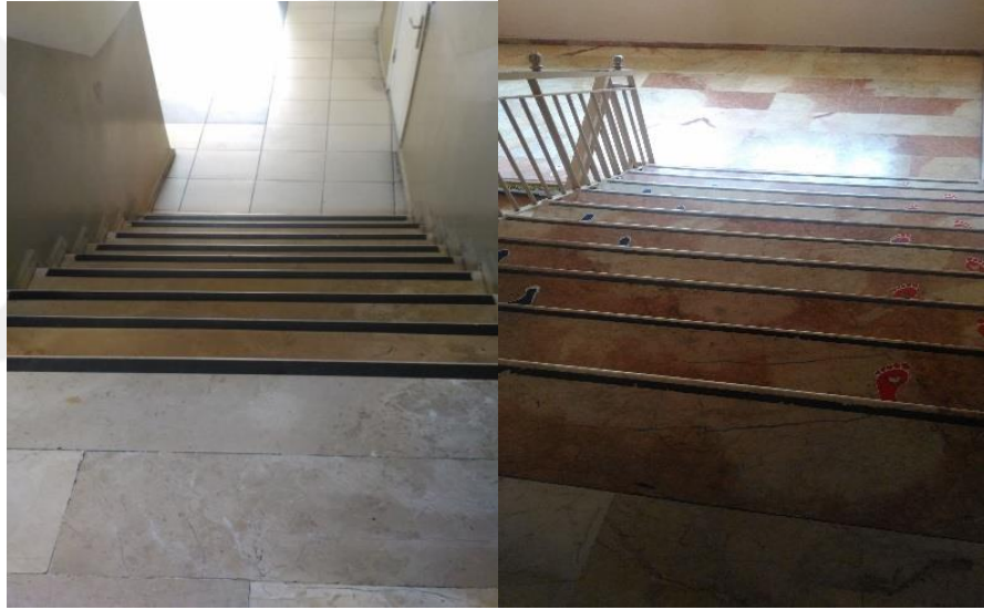
Şekil 3.5: Okullarda merdivenlerdeki kaymaz bantlar
