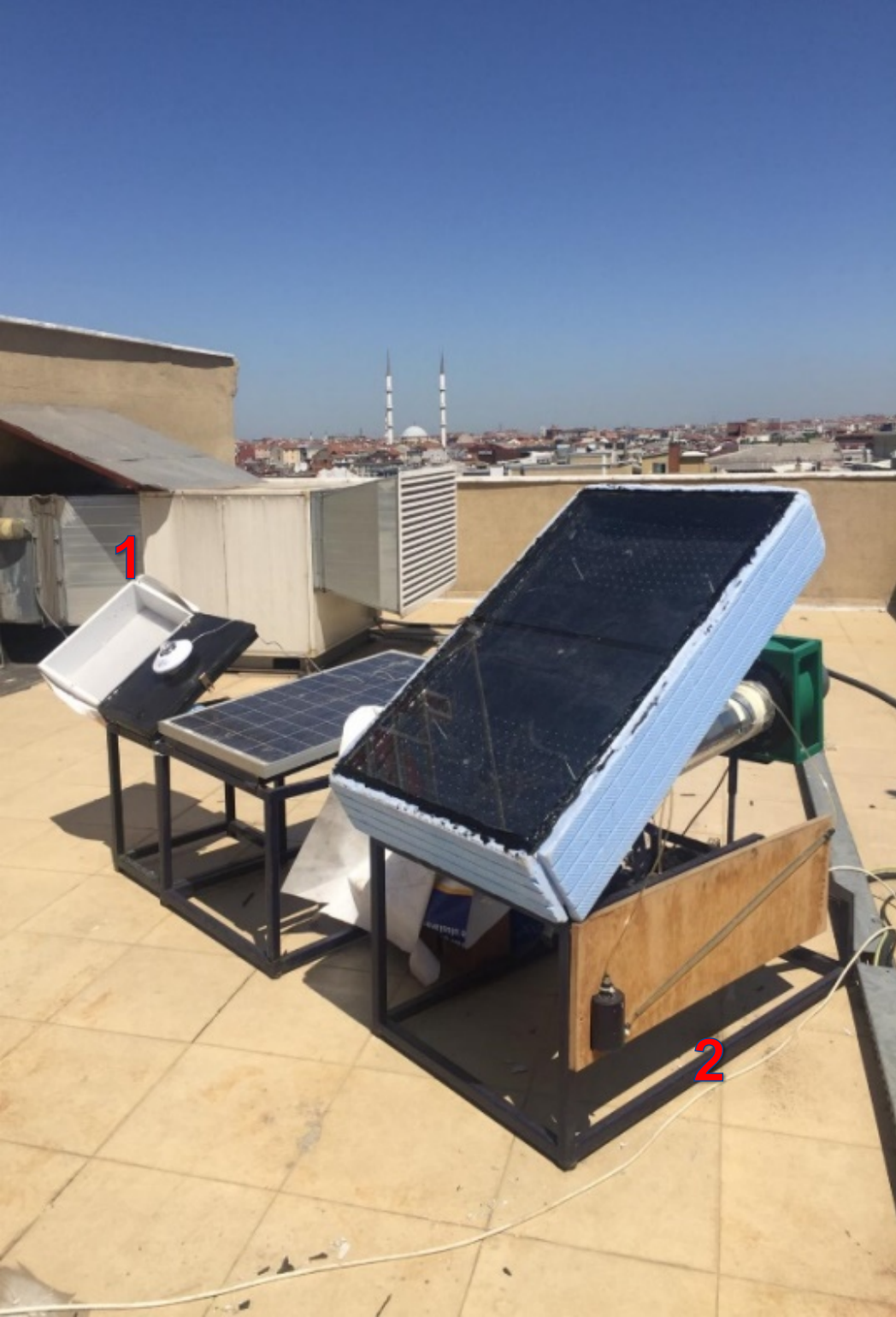
Şekil 3.3: Yapılan Çalışmaya Ait Kollektörün Tüm Sistem Görünümü
