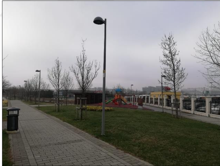
Şekil 4.38 Birinci bölgede yer alan park içindeki aydınlatma (Şekil 4.3:Foto-34)
