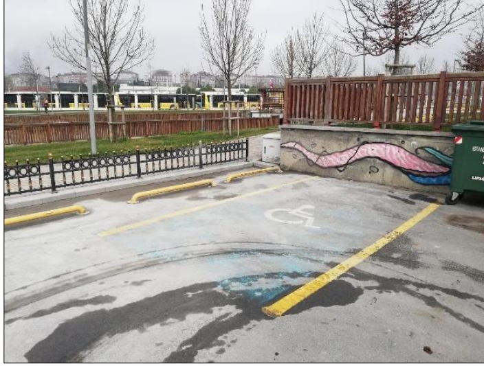
Şekil 4.16 Birinci bölge engelli otopark yeri -1 (Şekil 4.3:Foto-13)
