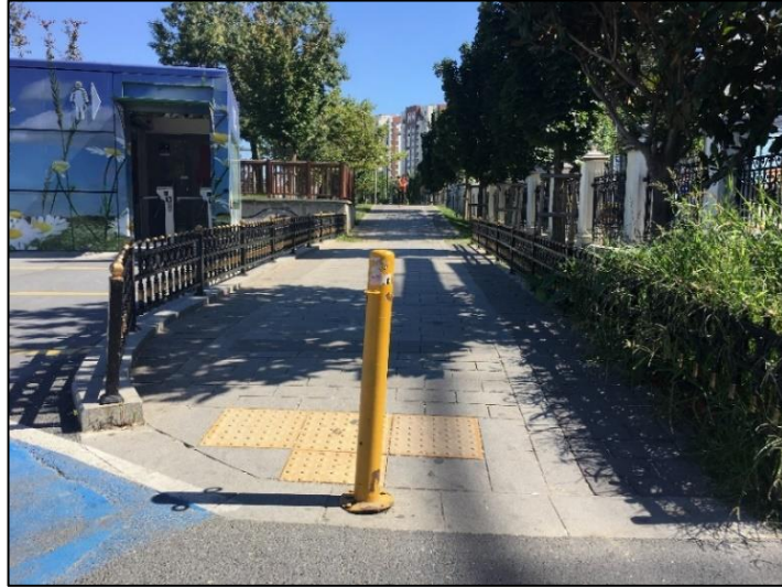
Şekil 4.12 Birinci bölge park içi kaldırım rampası (Şekil 4.3:Foto-9)
