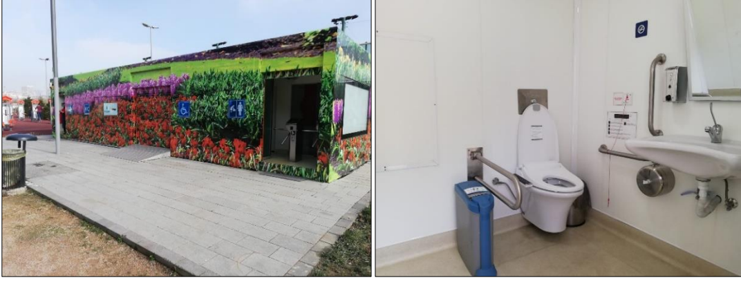
Şekil 4.39 Birinci bölgede yer alan tuvaletler (Şekil 4.3:Foto-35)
