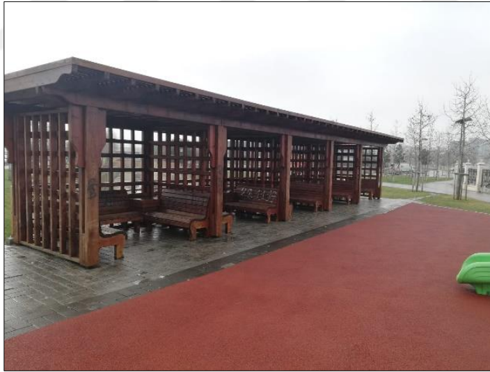
Şekil 4.40 Birinci bölgede üst örtü elemanı-1 (Şekil 4.3:Foto-36)
