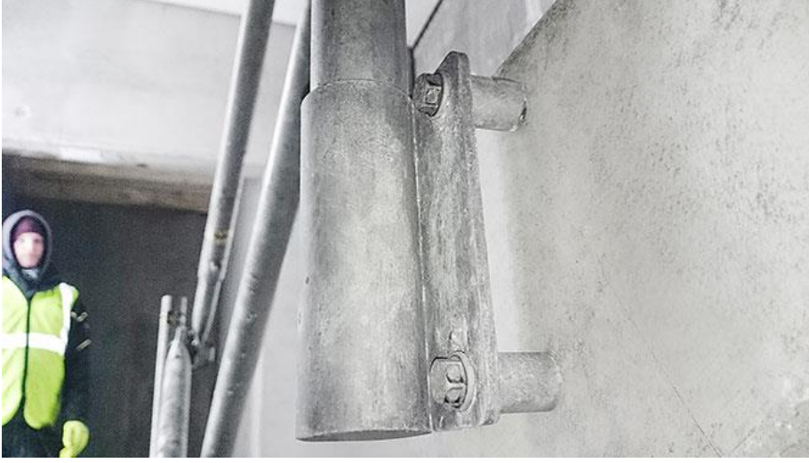
Şekil 7.28 : Merdiven Koruma Sistemleri Braketi (SAFETY RESPECT, 2018)
