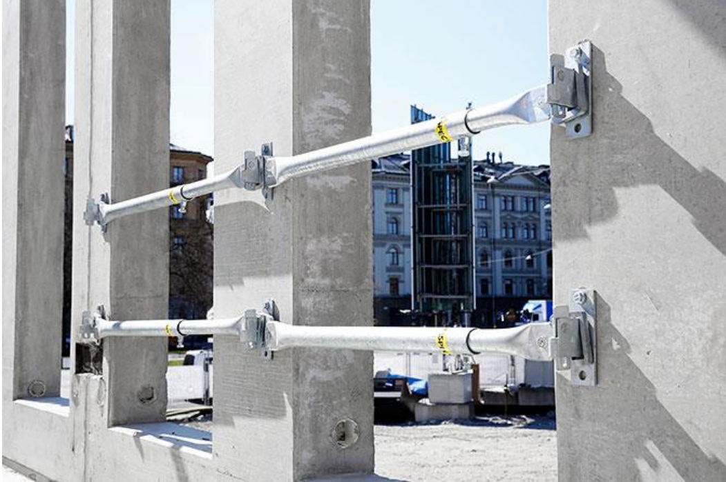
Şekil 7.23 : Duvar Açıklıklarında Ayarlanabilir Bağlantı (SAFETY RESPECT, 2018)
