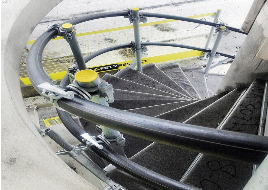
Şekil 7.27 : Merdiven Kenar Koruması Örneği 3 (SAFETY RESPECT, 2018)
