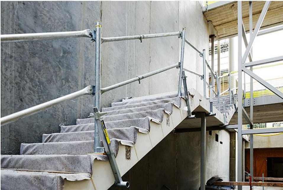
Şekil 7.25 : Merdiven Kenar Koruması Örneği 1 (SAFETY RESPECT, 2018)
