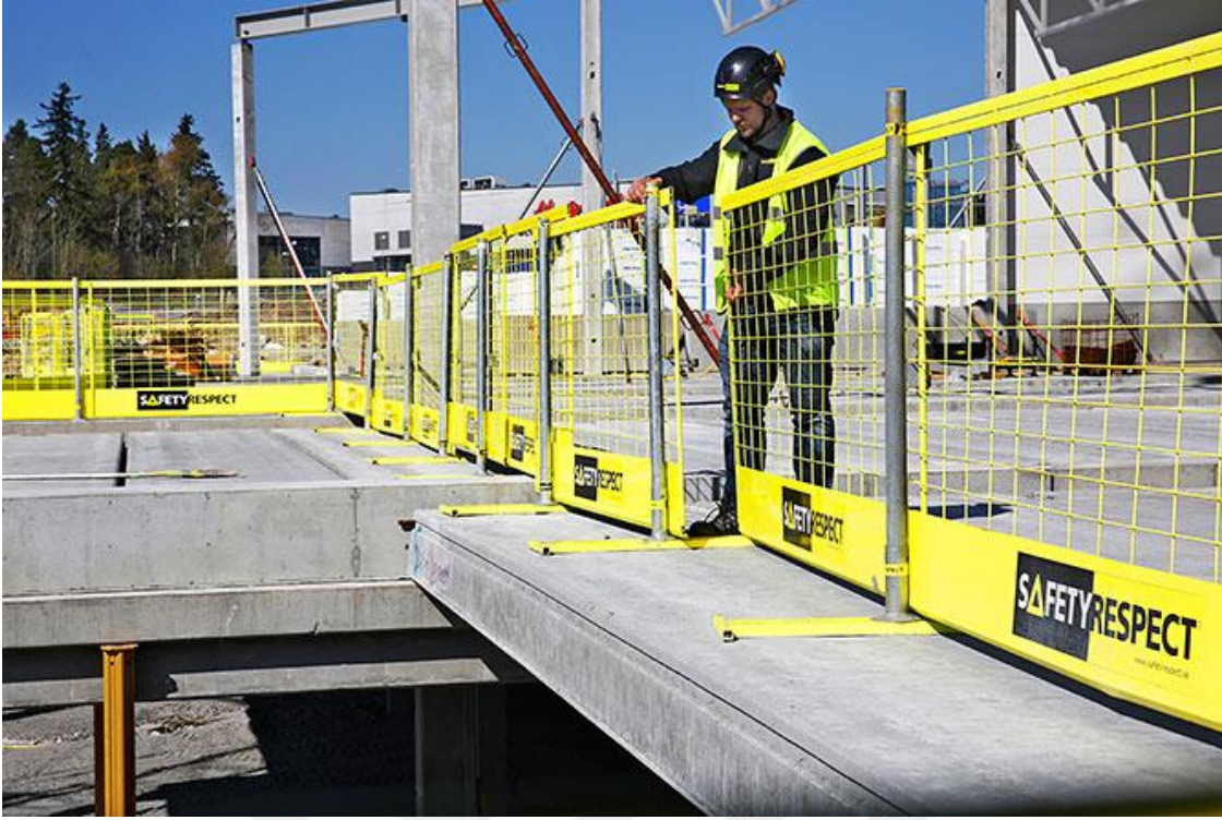
Şekil 7.24 : Döşeme İmalatları Kenar Koruması (SAFETY RESPECT, 2018)
