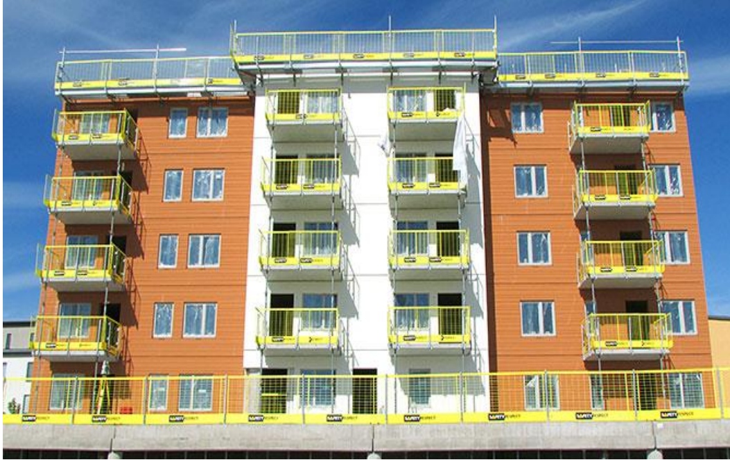
Şekil 7.21 : Balkon Kenar Koruması (SAFETY RESPECT, 2018)
