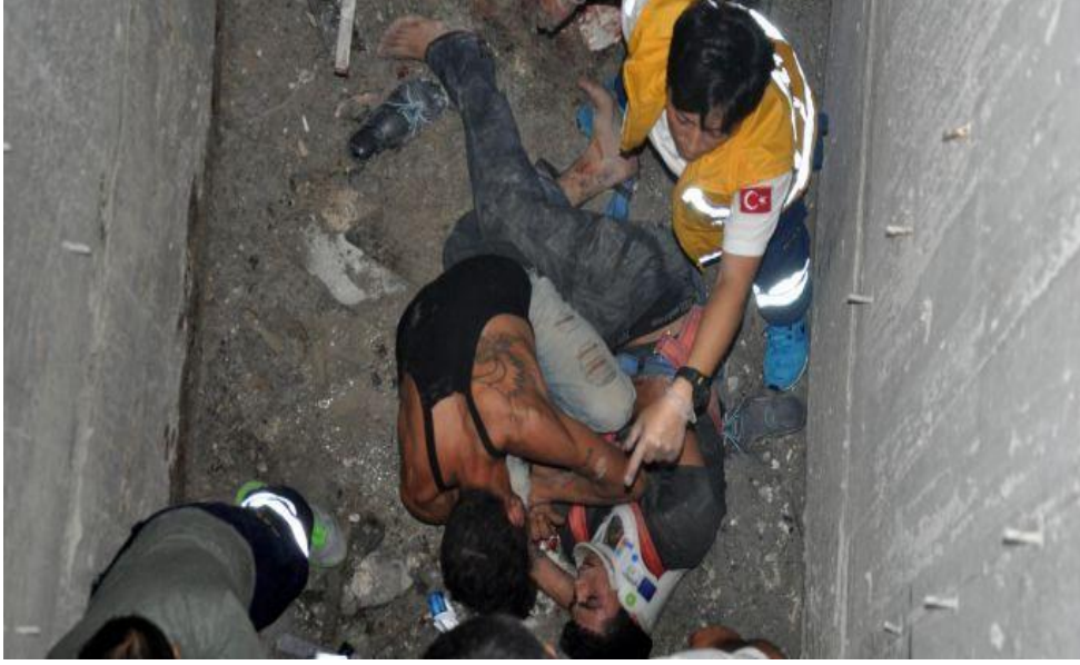
Şekil 6.7 : İnşaatın asansör boşluğuna düşen işçi yaralandı.
