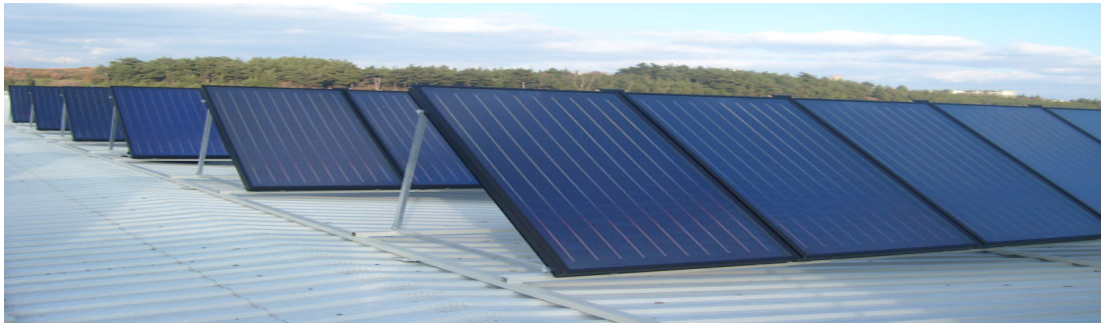
Şekil 3.8: Düz Çatılarda PV Uygulama[21]
