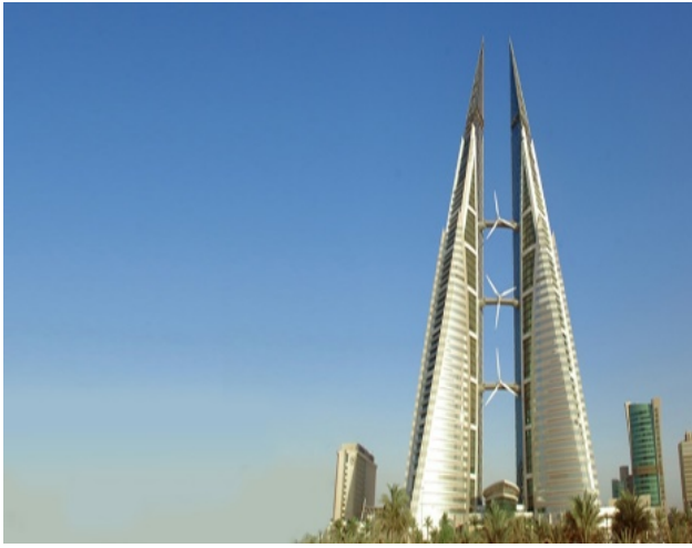
Şekil 3.20: Türbin-Bina Entegreli Rüzgar Enerjisi [34]
