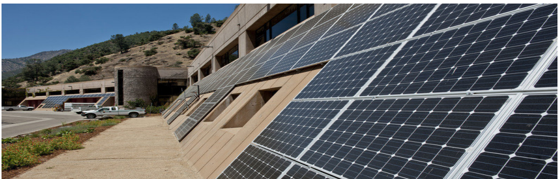
Şekil 3.14: Eğimli Düzlemsel Giydirme Cephe Uygulaması [29]
