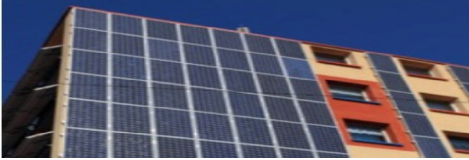
Şekil 3.12: Düzlemsel Giydirme Cephe Uygulaması [26]
