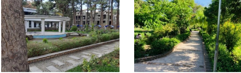
Şekil 4.5: Sol: çakıl ve taş malzeme yol, sağ: yığma taş malzeme yol
