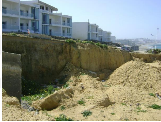
Şekil 3.8: incelenen yer seviyesinde toprak kayması
