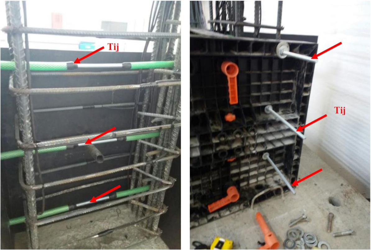
Şekil 2.9: LVDT Yerleştirilmesinde Kullanılan Tijlerin Montajı
