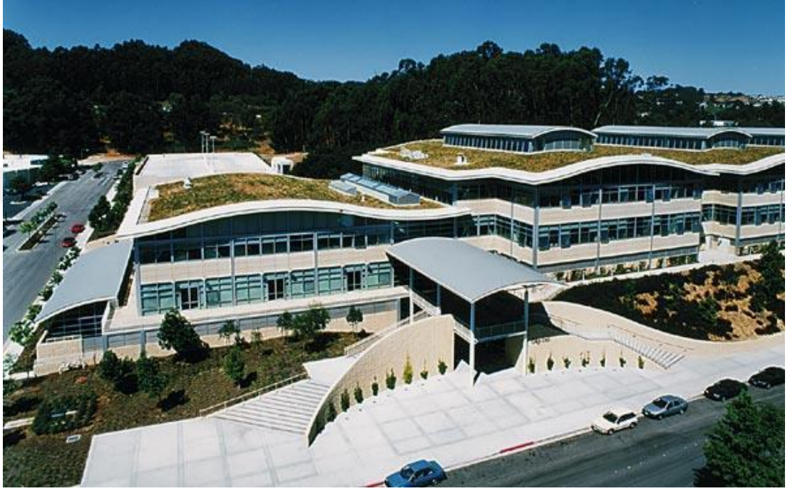
Şekil 4.1:Gap Genel Merkez Binası (URL-13)
