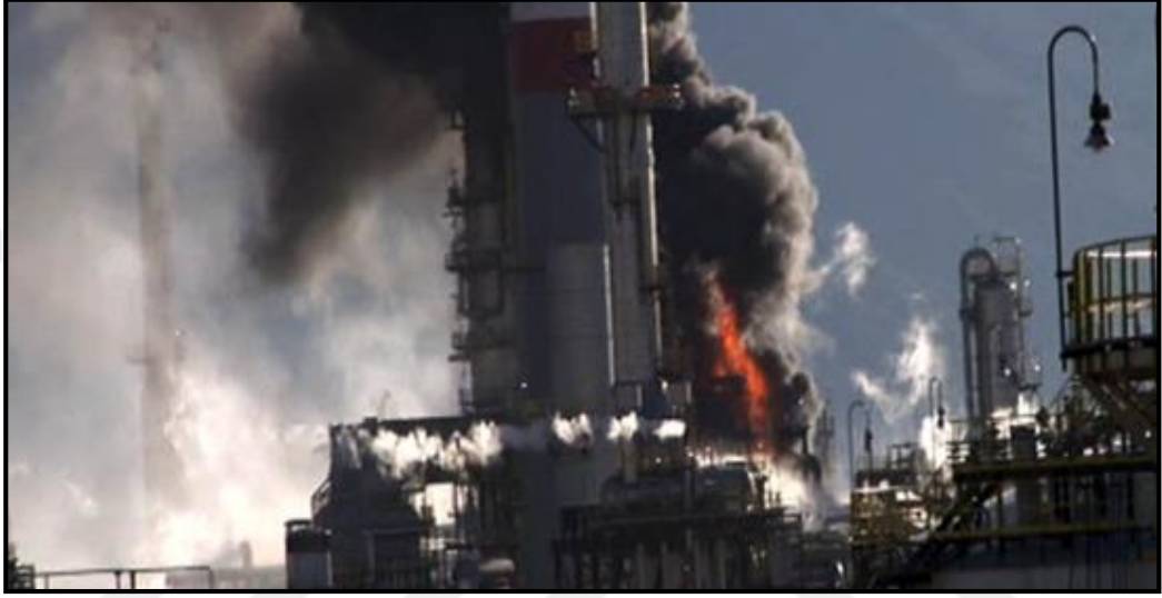
Şekil 3.17: 1999 yılında Kocaeli depreminde Körfez ilçesinde faaliyet gösteren Tüpraş İzmit Rafinerisi'nde çıkan yangın (URL-15)
