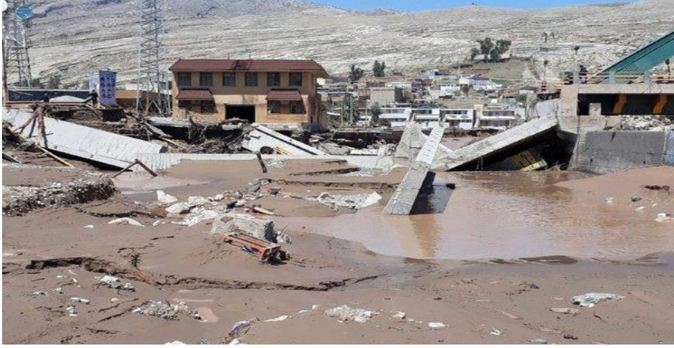
Şekil 3.12: 2013’de İran’ın Buşehir şehrinde deprem nedeniyle meydana çıkan sel ve taşkınlar (URL11)
