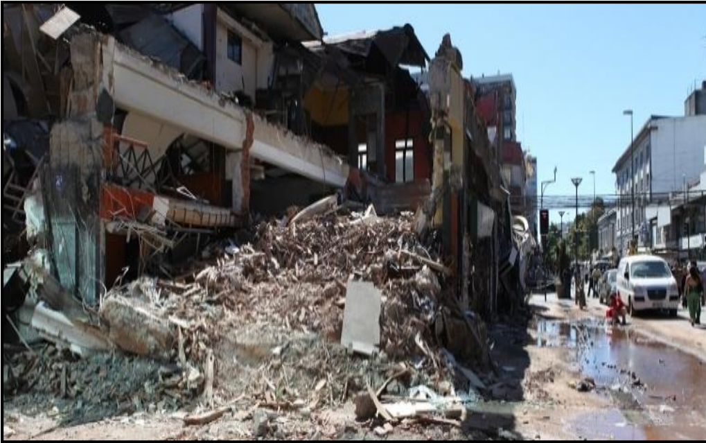
Şekil 6.4: 27 Şubat 2010'da Şili' nin Concepcion şehir merkezinde gerçekleşen deprem nedeni ile meydana gelen hasarlar (Walter Mooney, USGS)
