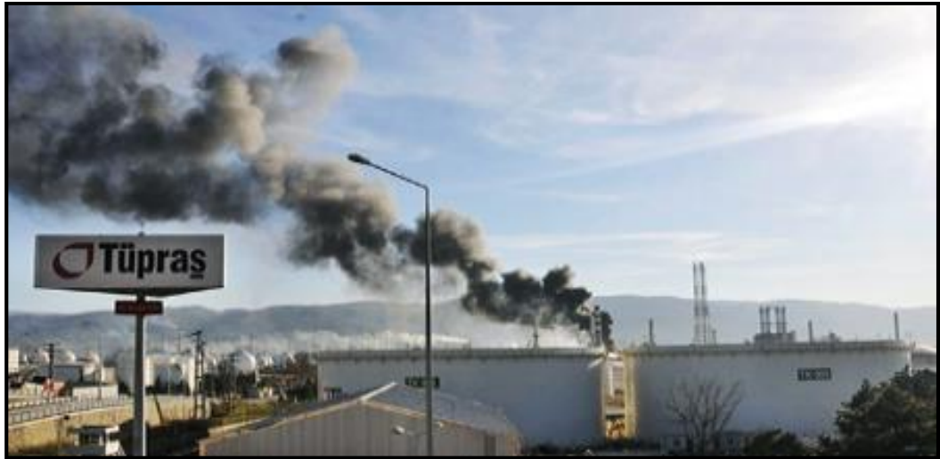
Şekil 3.18: 1999 yılında Kocaeli depreminde Körfez ilçesinde faaliyet gösteren Tüpraş İzmit Rafinerisi'nde çıkan yangın (URL-16)
