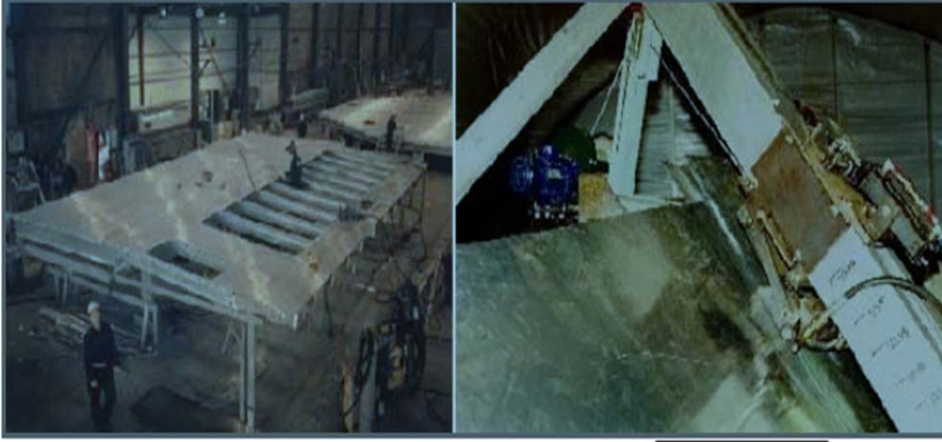
Şekil 2.4: Gemi alt bölmesinin yapım aşamasında SKK kullanımı
