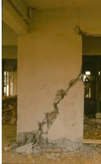
Şekil 1.1: Deprem sonrası oluşan hatalar [3]
