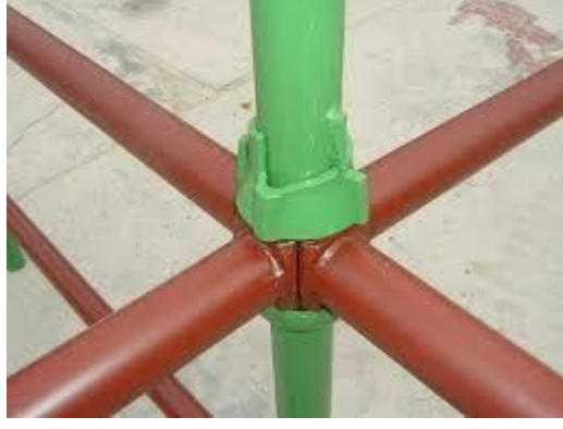
Şekil 2.9: Fincanlı İskele Kesit
