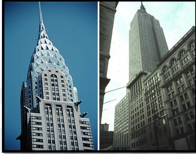
Resim 2. 3. New York Chrysler Binası (4)
