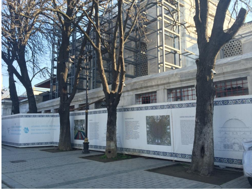
Şekil.5.2.23: Restorasyon çalışmaları devam eden medresenin dış yüzeyindeki bilgilendirme panosu (ELİF GÜNER)
