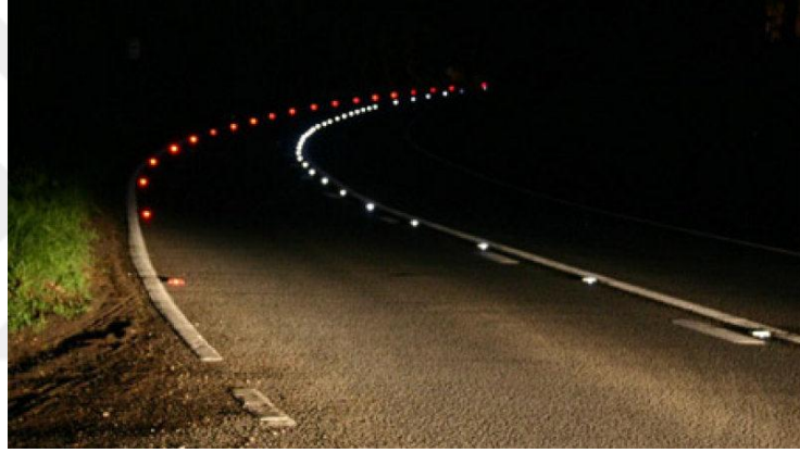
Şekil 4.93. Trafik Sinyalizasyonlarında Fotovoltaik Modül Uygulamaları.
