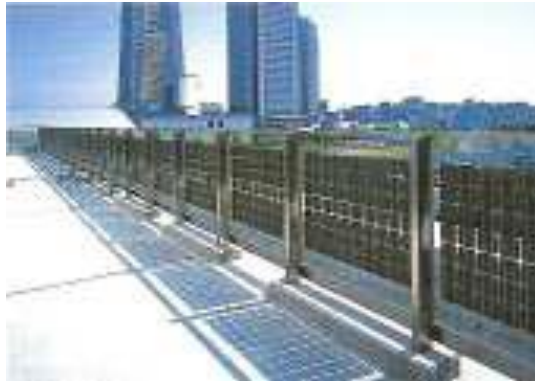
Şekil 4.75. Balkon Korkuluklarında Fotovoltaik Modül Kullanımı.
