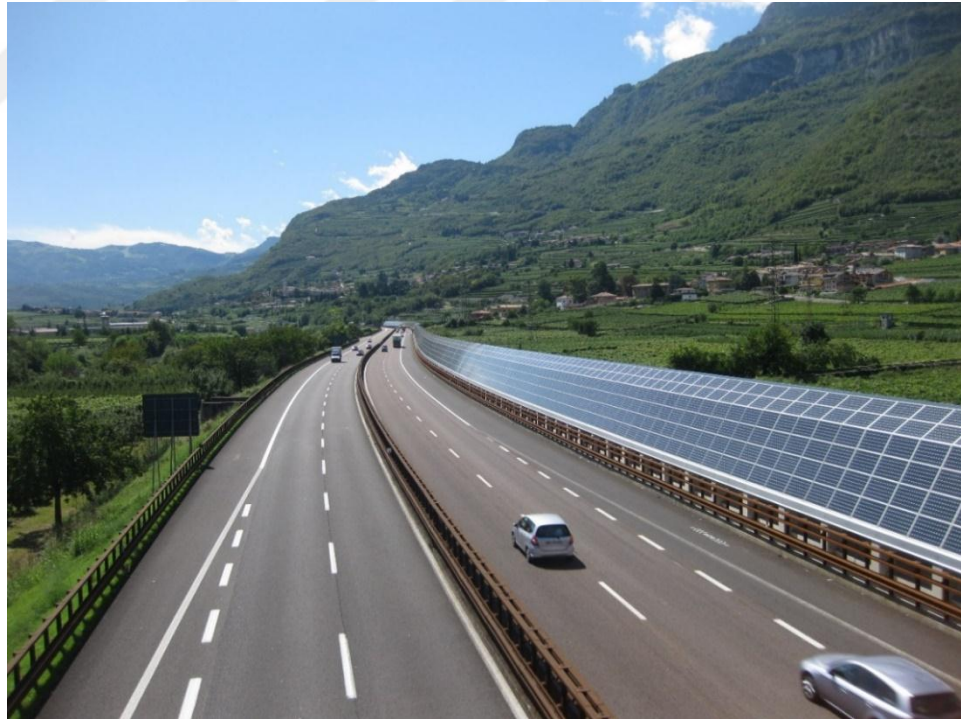
řekil 4.96. D nyadaki İlk Fotovoltaik Uygulanan Ses Bariyeri, İsvire.
