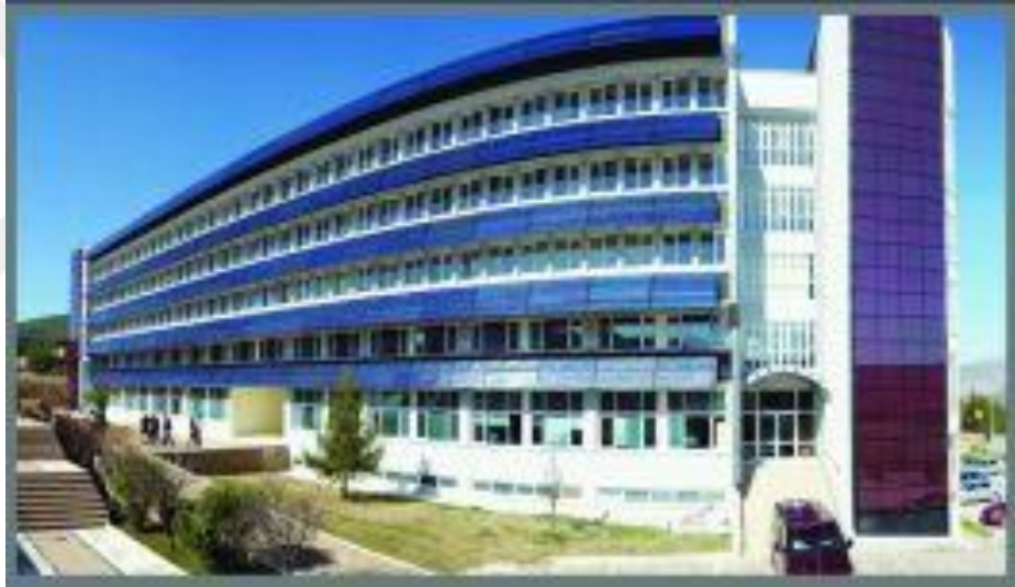
Şekil 5.25. Muğla Sıtkı Koçman Üniversitesi Yemekhane Binası Çatısı BIPV Çatı Uygulaması.
