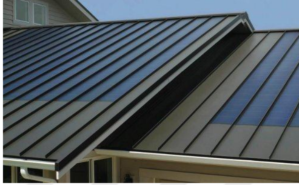
Şekil 4.30. Kenetli Sistem İnce Film Fotovoltaik Levhalar.
