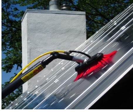
Şekil 4.7. Fotovoltaik Panel Temizliği.
